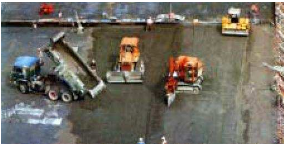
Abb.48 CSG-Verteilung in Situ
