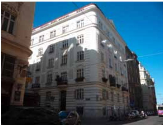
Abb. 56 Untere Viaduktgasse Nr. 12; 2011
