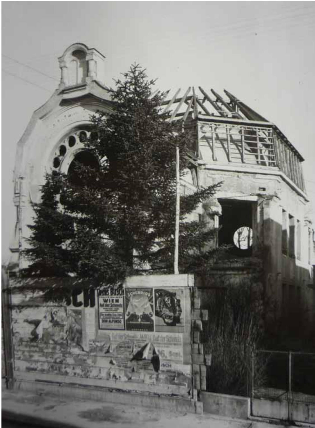
Abb. 110 Die zum Teil zerstörte Synagoge 1941
