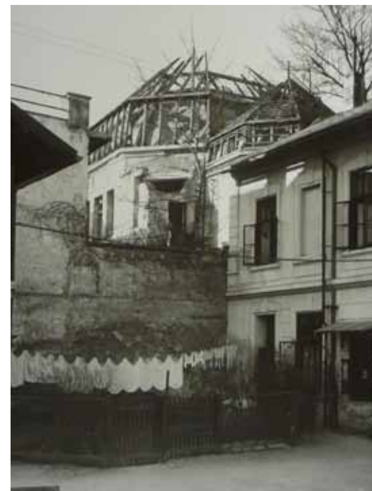
Abb. 109 Die zum Teil zerstörte Synagoge 1941
