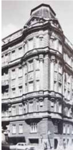
Abb. 53 Untere Viaduktgasse Nr. 8
