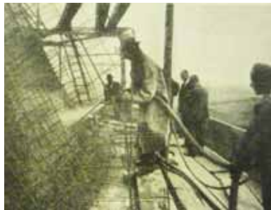
Abb. 84 li: „Torketieren des unteren Teils“ (Trockenspritzverfahren)
