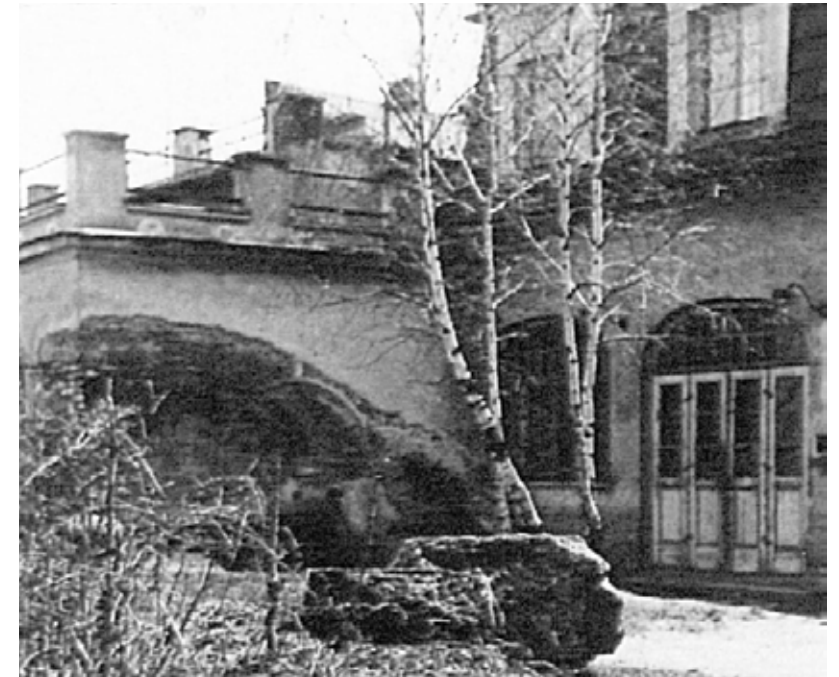
Abb. 20 Teilweise zerstörtes Amtsgebäude; vermutlich 1987
