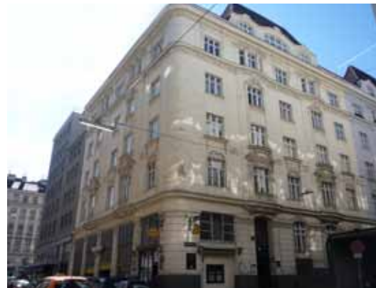
Abb. 57 Untere Viaduktgasse Nr. 14; 2011
