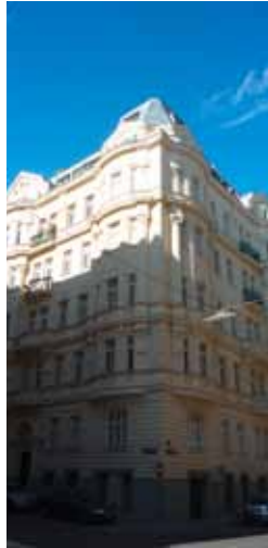
Abb. 54 Untere Viaduktgasse Nr. 8; 2011
