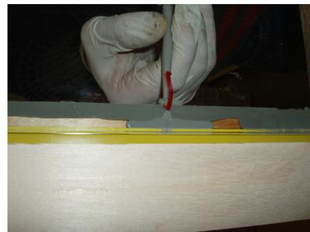
**Abbildung 46:** Verpressen der Fehlstellen in der Schubverklebung
