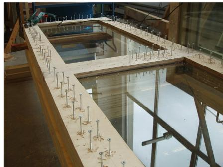
**Abbildung 53:** Arbeitsvorgang der Verschraubung
