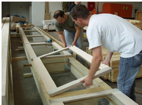
**Abbildung 52:** Auflegen der Holz-Glas-Verbundelemente auf den Rahmen
