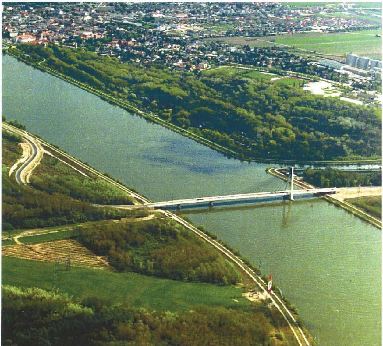
Abb 7-45a: Messgebiet Rosenbrücke und Umgebung (Quelle: Stadtgemeinde Tulln an der Donau)
