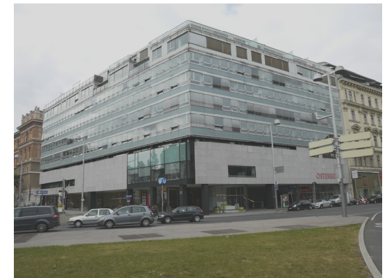
Abb. 21: Akademiehof, Fassade, Arch. Gustav Pechl und Roland Rainer
