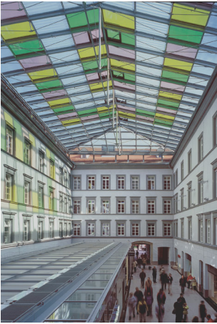
Abb. 22: Rathausgalerie Innsbruck, überdachte Passage, Arch. Dominique Perrault & RPM & ATP
