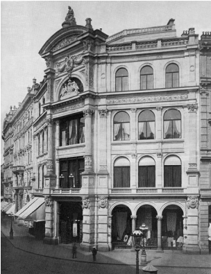
Abb. 25: Haas Haus, Fassade Ende 19. Jhdt., Arch. Siccardsburg und Van der Nüll
