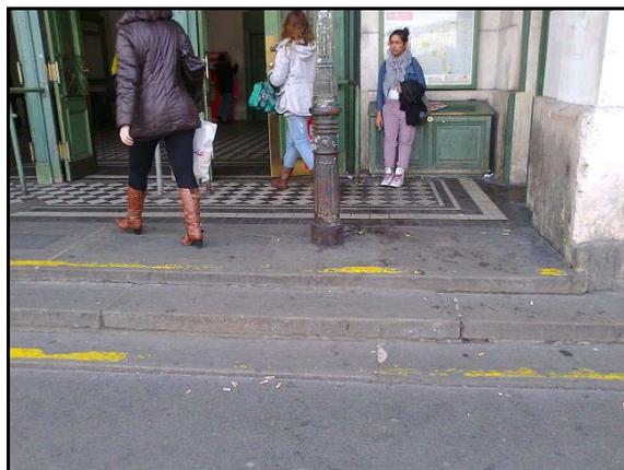
**Abbildung 117: Schlecht gekennzeichnete Stufen**
