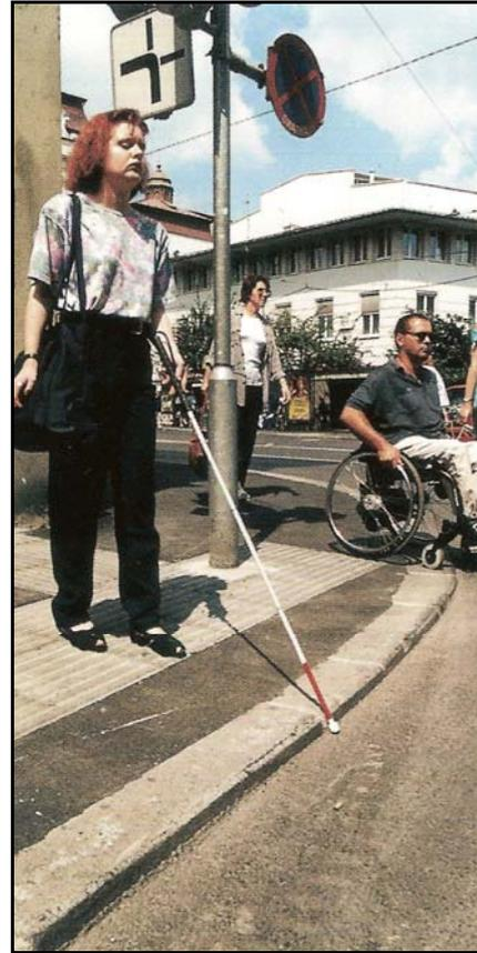
**Abbildung 111: Taktile Bodeninformation und Tastkante bei einem Straßenübergang**
