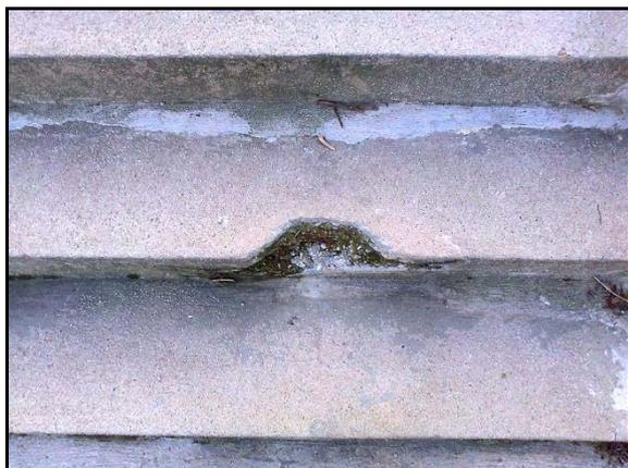
**Abbildung 116: Stufe – Stolpergefahr**
