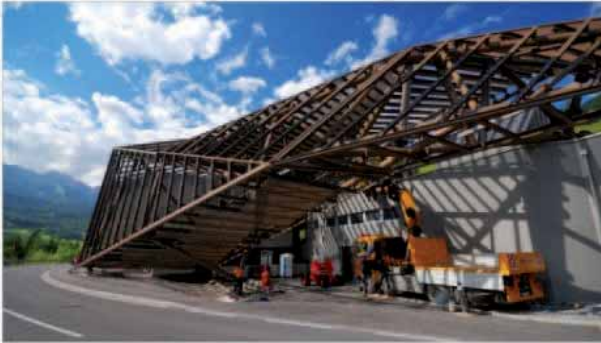
Abb.100: Lüftungsgebäude am Roppener Tunnel
