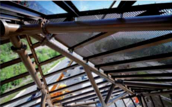
Abb.102:Fassadenkonstruktion des Lüftungsgebäudes
