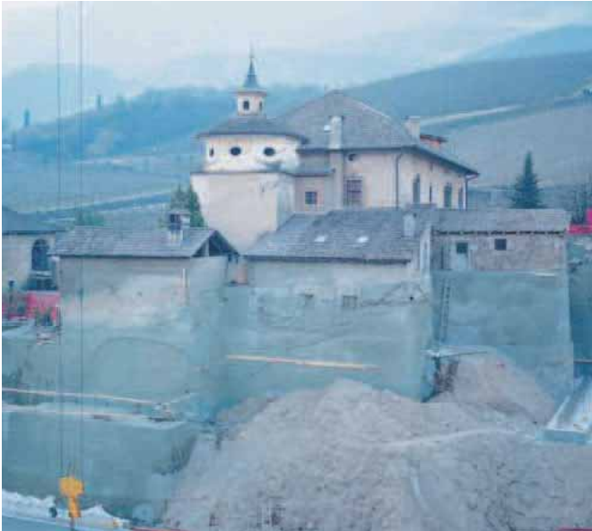
Abb.16: Baustelle Weingut Manincor
