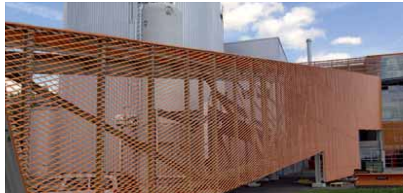
Abb.103:Streckmetallfassade mit Cortene Stahl Optik
