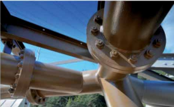
Abb.101:Knotenpunkt am Lüftungsgebäude
