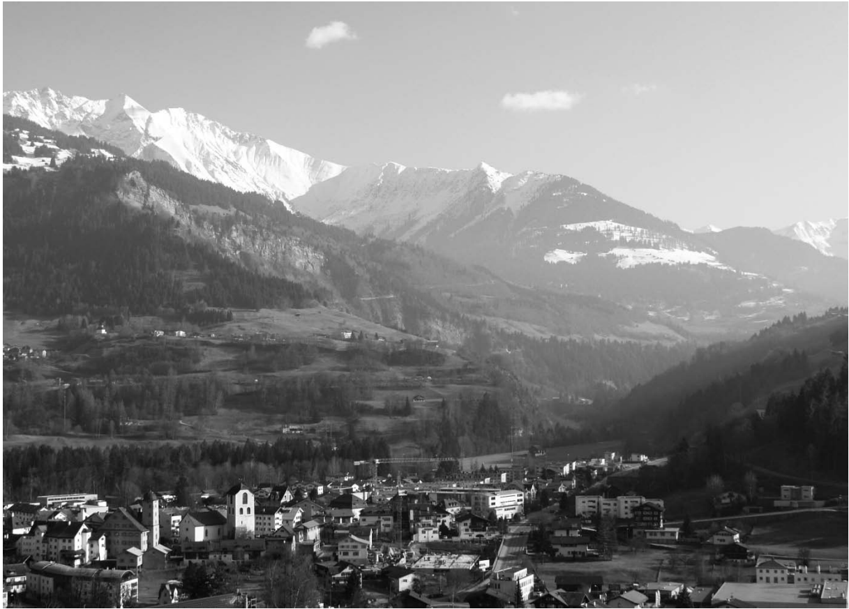
Abb. 6 – Panorama Ilanz (Blick gen Süden). Neubau der Vorderrheinbrücke rechts des Bildes
