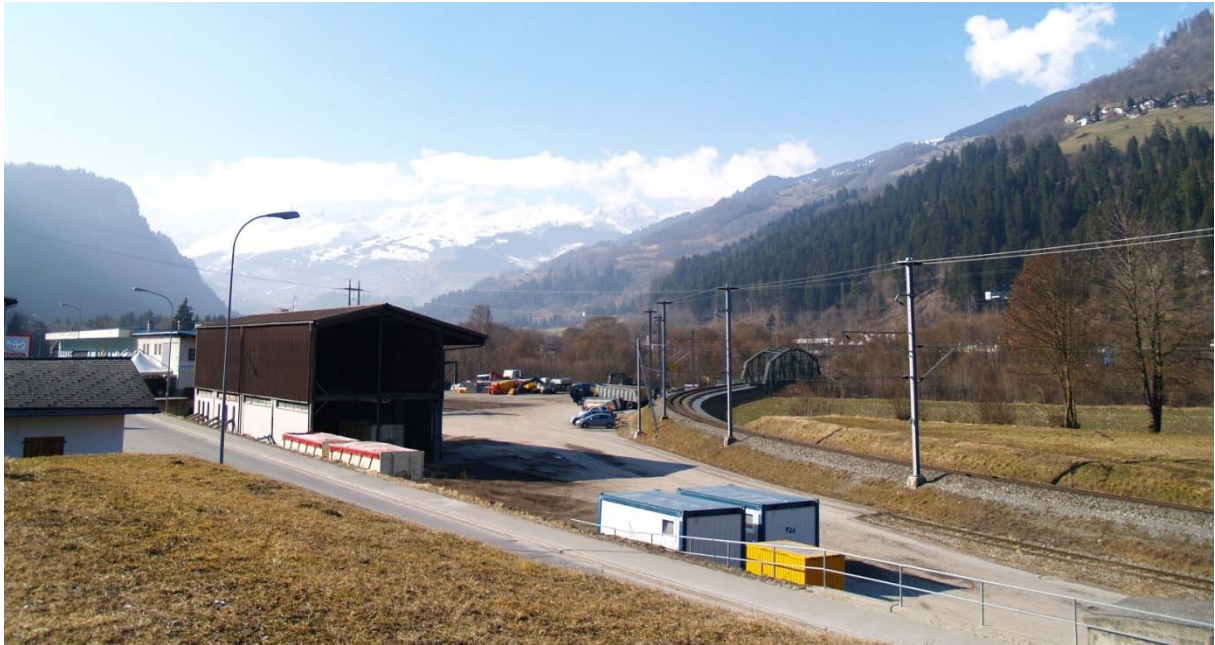
Abb. 3 - Blick gen Westen. Im Hintergrund "alte RhB - Brücke", im Vordergrund links: Mosterei (Abbruch)
