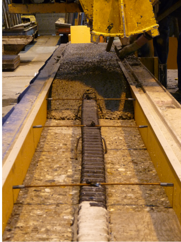
Abbildung 4.2: Betonieren der vorgespannten Versuchskörper
