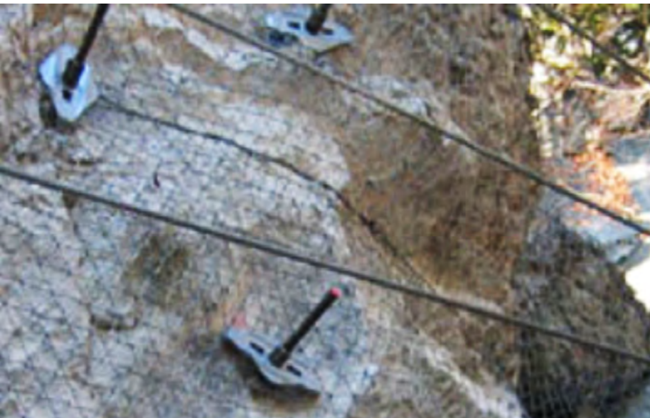
Abb. 13: Felsverankerung von Geotest
