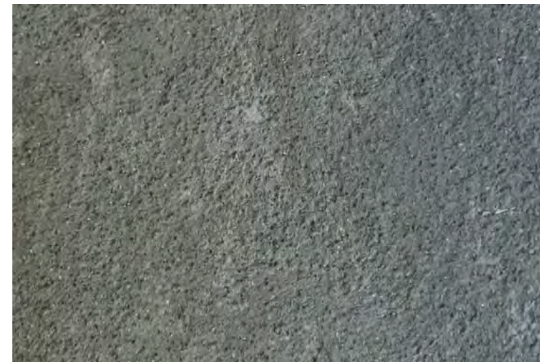
Abb. 23: Spritzbeton von Betonfibel
