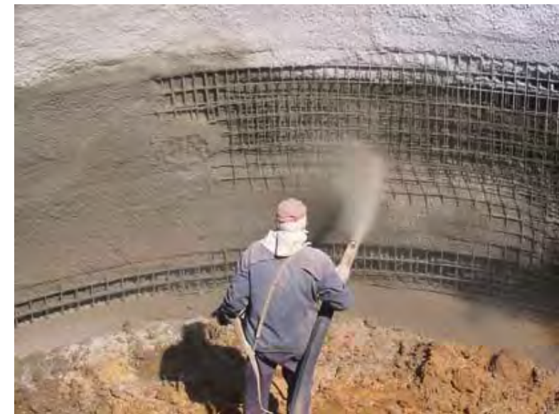
Abb. 24: Spritzbeton von Bültmann-Bau
