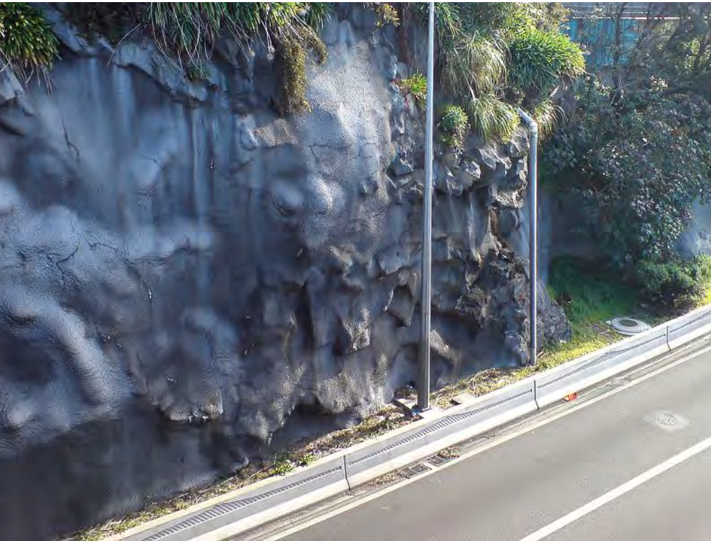
Abb. 21: Mit Spritzbeton stabilisierte Felswand in Auckland, Neuseeland
