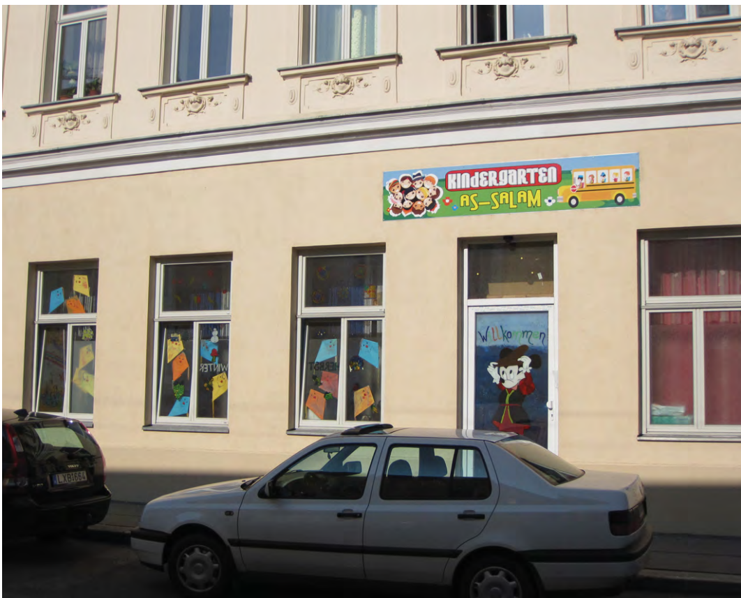
089 Kindergarten „Al Selam“
