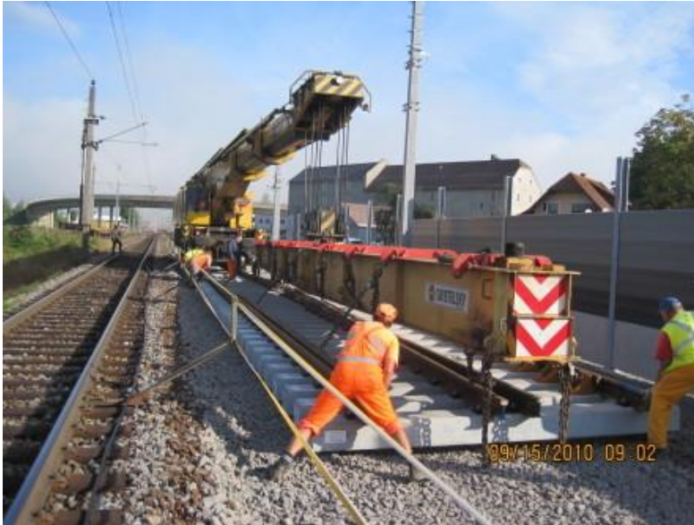
Abbildung 7 Bf. Leibnitz - Gleisverlegearbeiten am Bahnhof-Südkopf. Quelle ÖBB.
