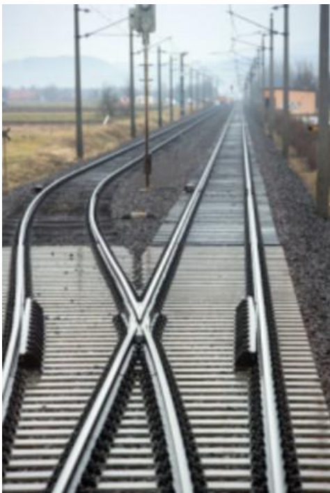
Abbildung 36 Zweigleisiger Ausbau Werndorf-Spielfeld Strass. Quelle ÖBB
