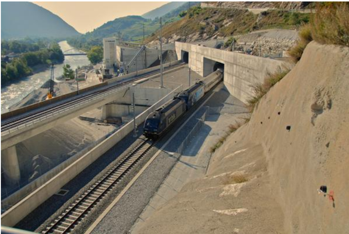
Abbildung 50 Südportal des Lötschberg Basistunnels. Quelle Bundesamt für Verkehr
