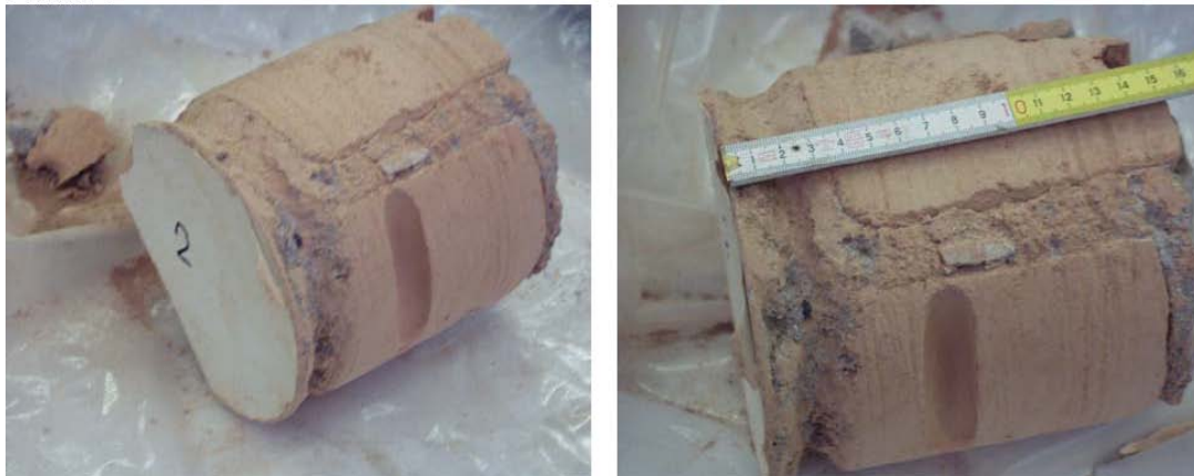
Bild 177: Bohrkern 2, Mauerputz 3,5 cm, entnommen aus [137]
