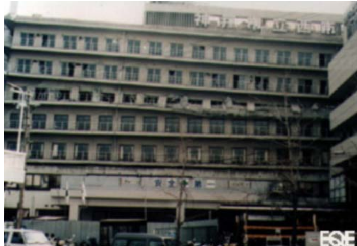
Bild 164: Weiches Obergeschoß, entnommen aus [62]
