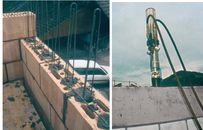
Bild 156: Links, bewehrtes Mauerwerk, Rechts, Vorspannen von Mauerwerk [3]
