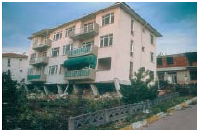
Bild 163: Weiches Erdgeschoß, entnommen aus [3]
