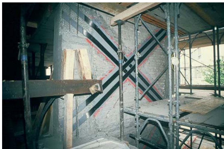
Bild 157: Verstärkung mittels Kohlefaserplatten, entnommen aus [3]
