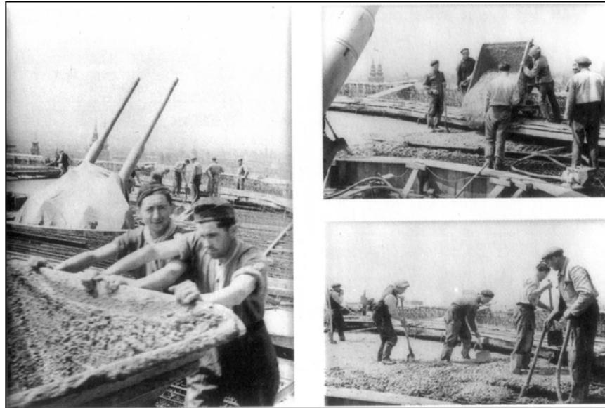
Abb. 34: Betonierarbeiten am GT Stiftskaserne. Am linken Bild ist deutlich zu erkennen, dass die Fliegerabwehrkanonen bereits vor Fertigstellung der Türme montiert wurden.
