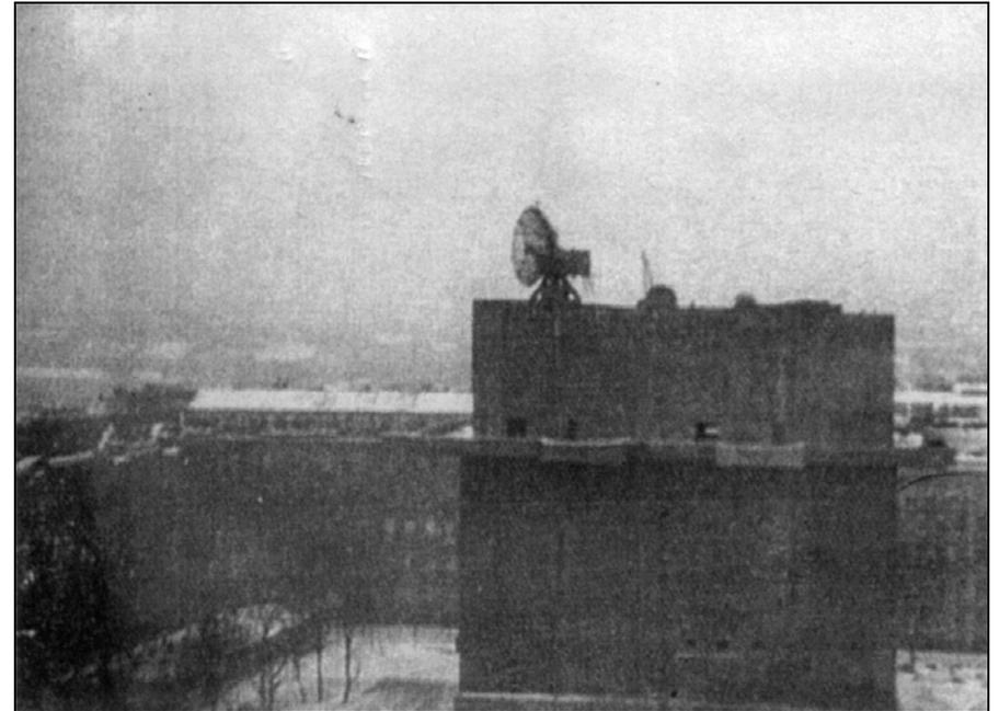
Abb. 14: Leitturm im Arenbergpark mit dem Funkmessgerät FuMG 65 „Würzburg-Riese“
