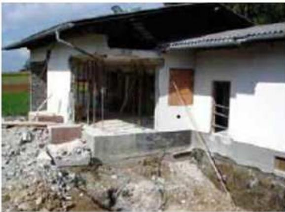
Abbildung 26: Grundrissänderungen und Dachabbruch am Bestandsgebäude [38]
