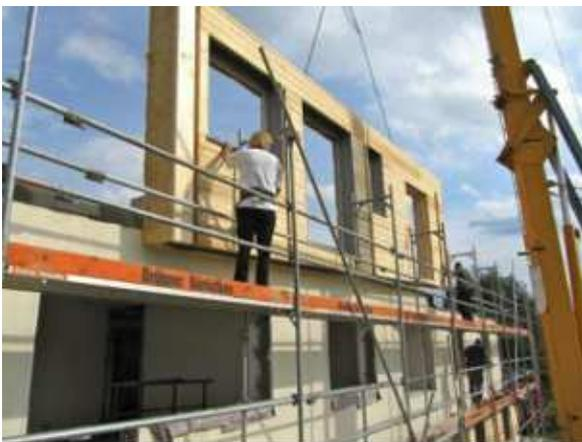
Abbildung 39: Vorgefertigte Holzkassettenfassade [41]
