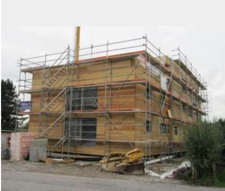
Abbildung 40: Fertigteile Holz-Kassettensystem ohne Wetterschutzverkleidung [41]
