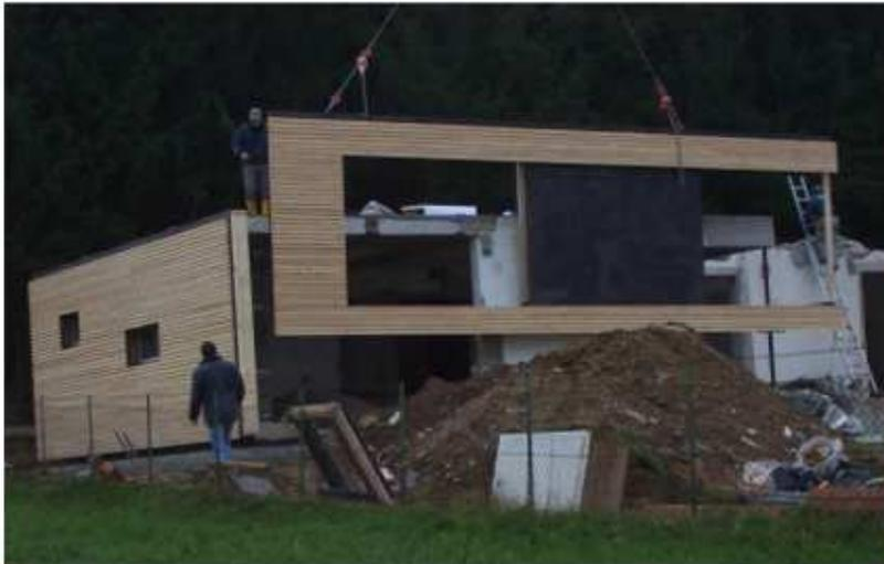
Abbildung 29: Fertigteile-Holzriegel-Bauteile und Zellulosedämmung [39]
