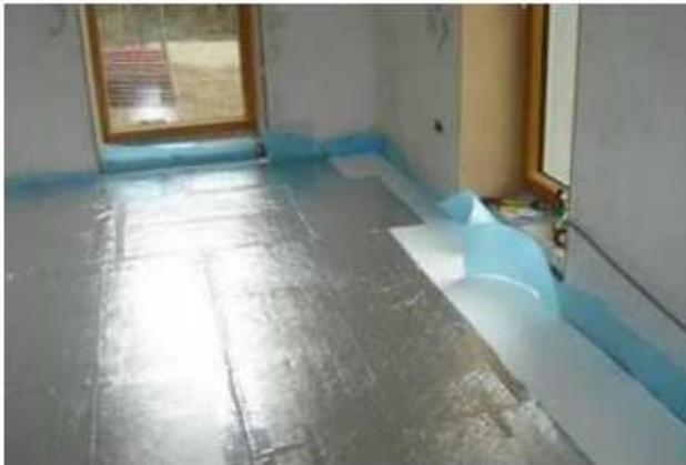
Abbildung 28: Kellerdeckendämmung mit Vakuumdämmplatten [39]
