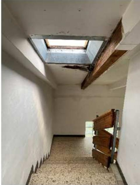
*Abbildung 81: Wasserschäden im Bereich des Daches [48]*
