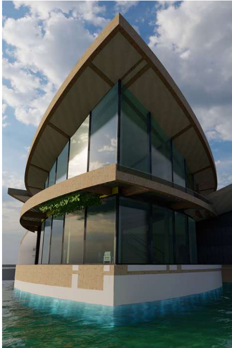
Abbildung 72: Pfosten-Riegel-Fassade ohne Verschattungselemente, Eigene Abbildung.
