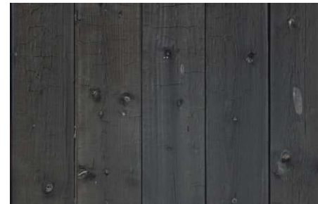
Abbildung 76: Hausbootfassade u. Innenwand Materialität: Carbonisiertes Lärchenholz
