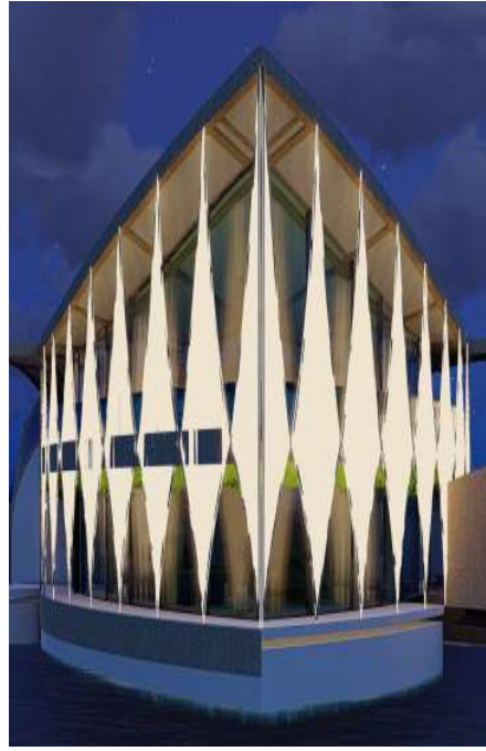
Abbildung 73: beleuchtete und beschichtete Glasfaser-Textilfassade, Eigene Abbildung.
