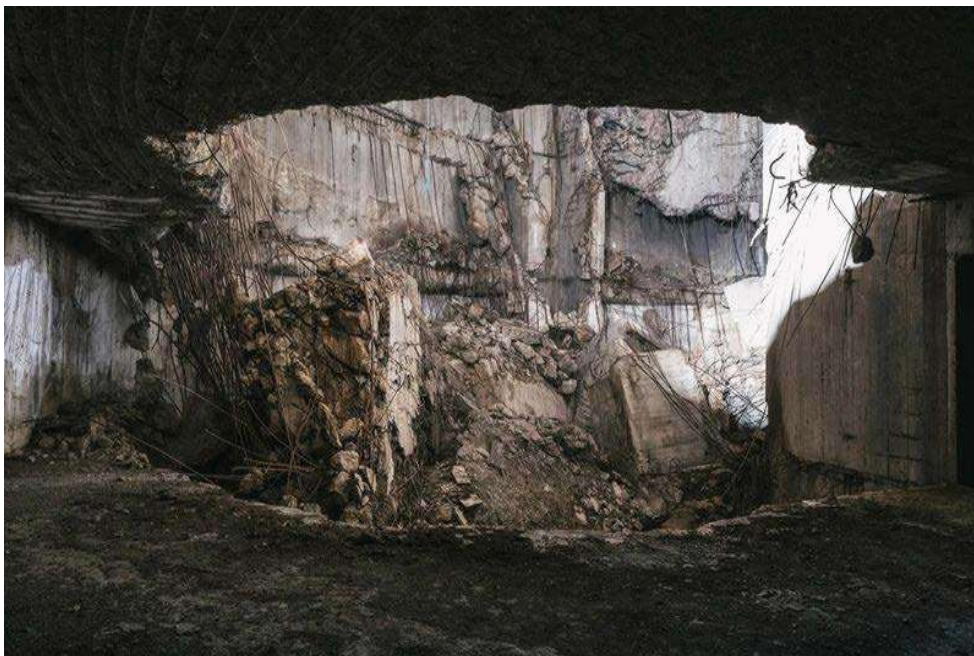
Abb.68 Eingestürzte Zwischendecken in den oberen Stockwerke
