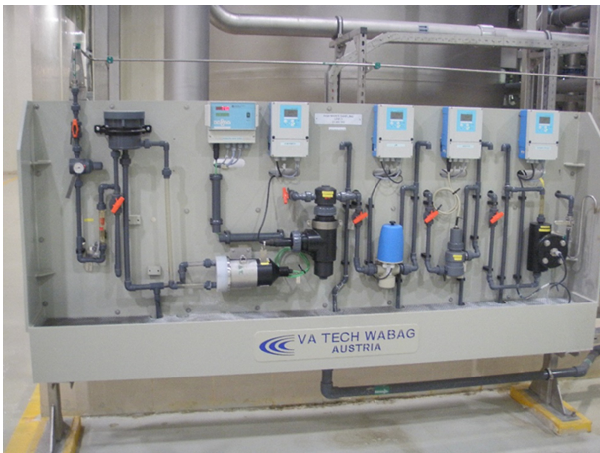
Abbildung 5: Messpanel für Nitrat, Trübung, pH-Wert, Sauerstoff und Leitfähigkeit
