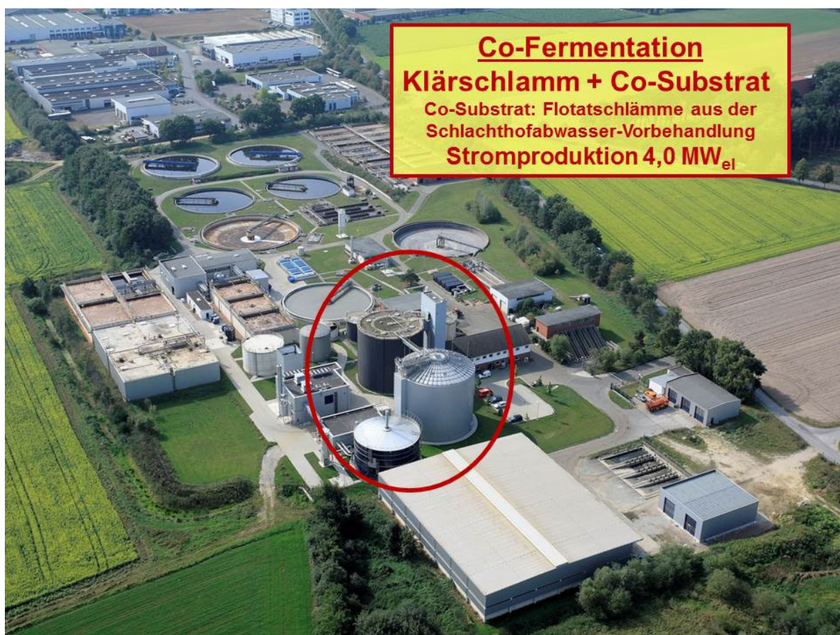
Abbildung 3: Kläranlage Rheda-Wiedenbrück mit Co-Fermentation
