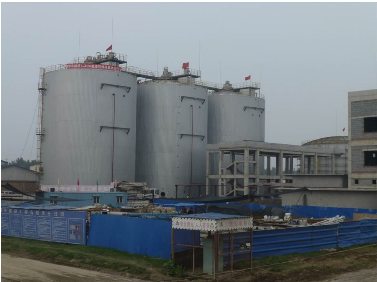
Abbildung 4: Co-Fermentation von Rückständen aus der Penicillinproduktion in Shijiazhuang/ China
