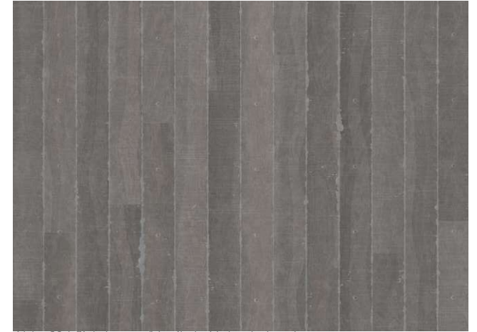
Abb. 60 | Sichtbeton (Vertikale Holzschalung)
