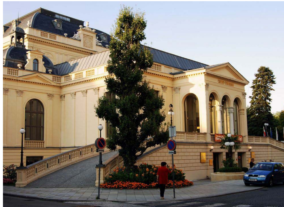
Abb. 14 | Casino Baden bei Wien, erbaut zwischen 1884 und 1886 von den Architekten Eugen Fassbender und Maximilian Katscher.
