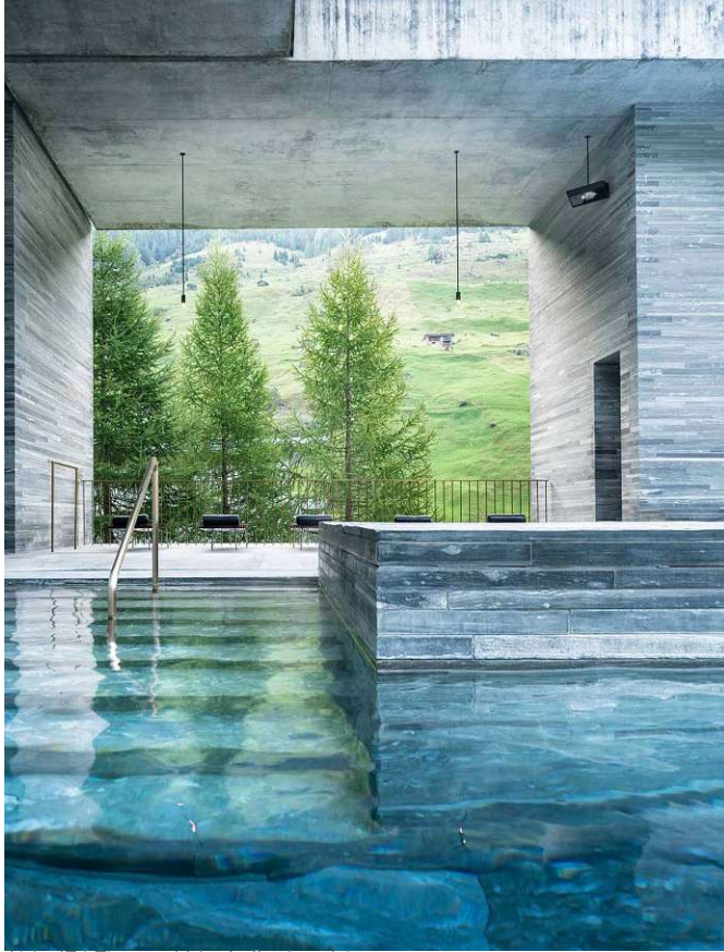
Abb. 17 | Therme Vals: Außenbereich
