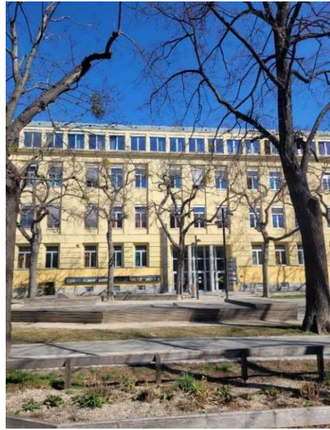
Abbildung 49: Schuleingang in der Franklinstraße. Eigene Aufnahme.
