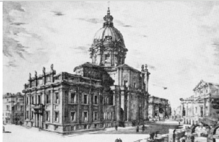
Abb. 66: Akademiepalast vor der Kirche der Heiligen Luca und Martina. Begonnen 1929, unterbrochen 1932 und danach abgerissen, um den Parkanlagen Platz zu schaffen
