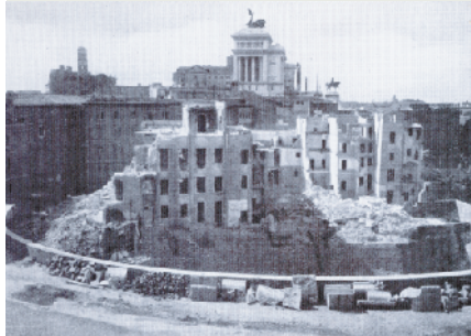
Abb. 67: Blick von den trajanischen Märkten auf den Abbruch der mittelalterlichen bzw. neuzeitlichen Bebauung auf dem Trajansforum, 1932.
