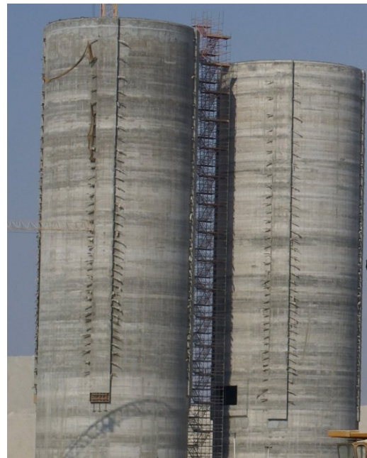
Abb. 45 Zementsilos als vorgespannte Konstruktion [2.18]
