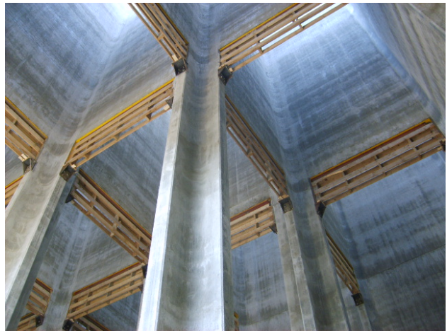
Abb. 42 Beginn von bis jetzt nicht vorhandenen Zellenwänden in der Höhe [2.59]
