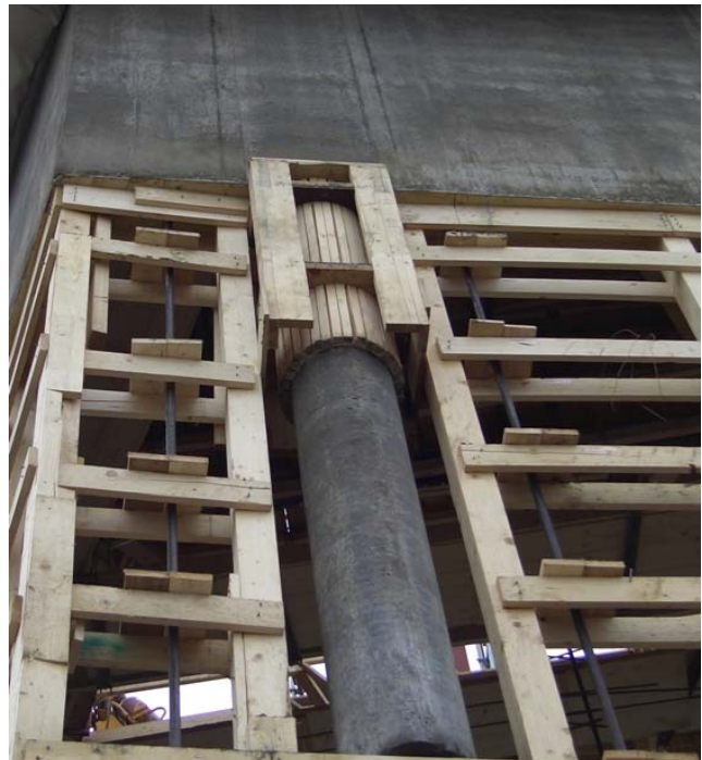
Abb. 58 Aussparung und Kletterstangenaussteifung [2.24]
