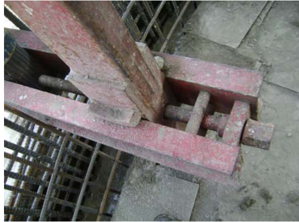
Abb. 32 Gleitbock mit beweglichen Rahmenstielen zur Wanddickeänderung [2.40]
