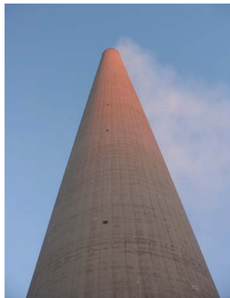
Abb. 1 Schornstein des Kohlenkraftwerkes „Ponte“ [2.56]
