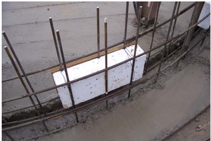
Abb. 60 Styroporeinbauteil zur Hinterlassung einer Öffnung (Eigenfoto)
