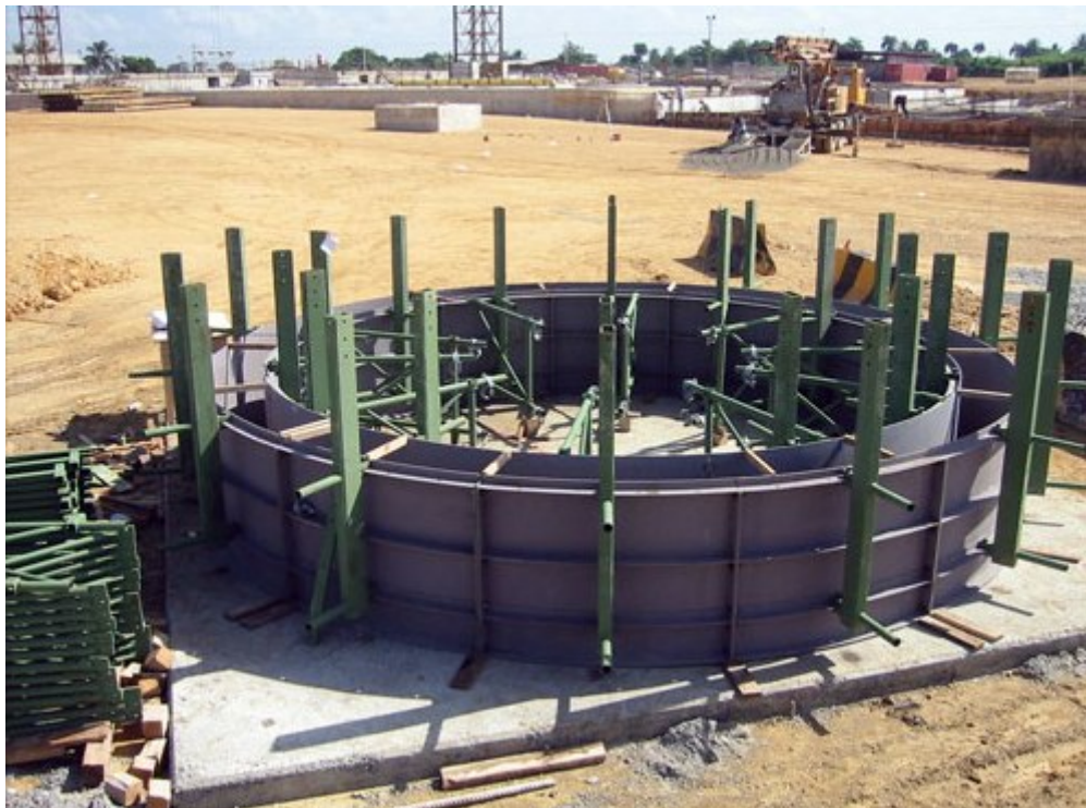
Abb. 21 Schalhaut aus Stahl [2.37]
