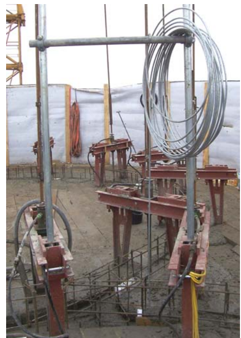
Abb. 38 Blitzdrahtrolle (Eigenfoto)
