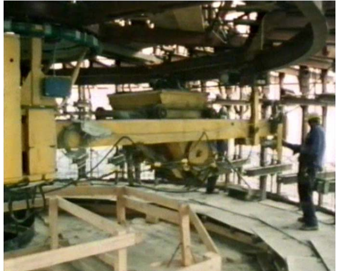
Abb. 53 Ansicht einer Betonverteileranlage [2.1]
