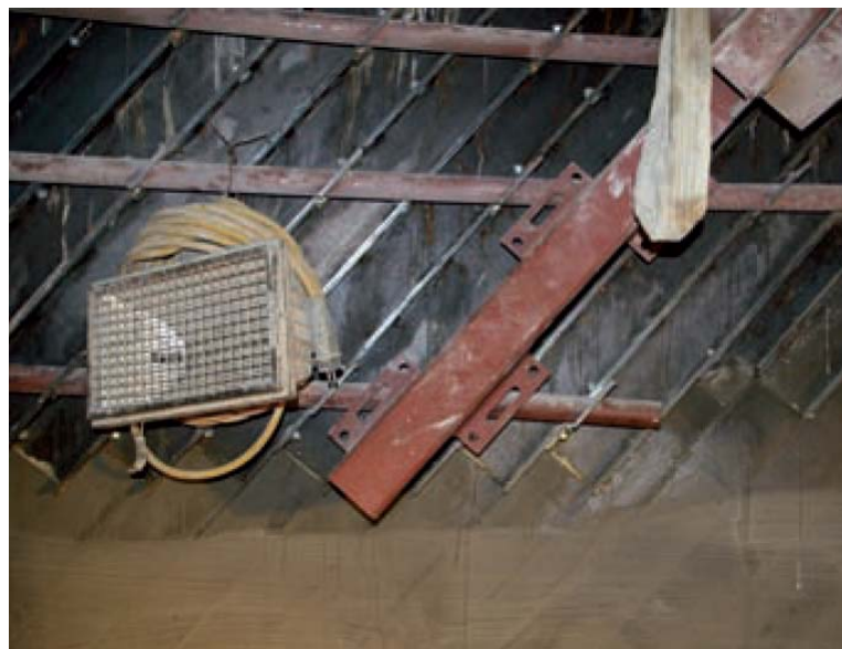
Abb. 17 Schalhaut der um 49^\circ geneigte Schalungsplattform [2.35]
