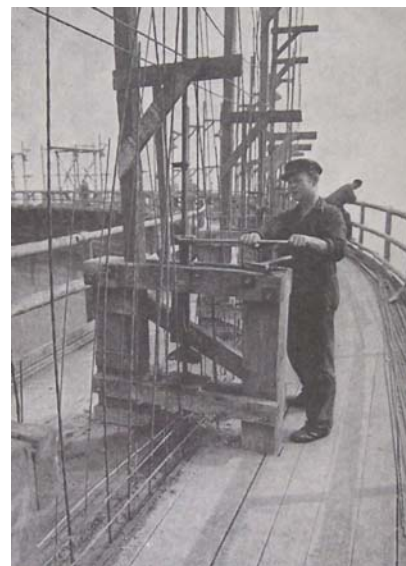
Abb. 12 Manuell betätigte schraubspindelbetriebene GS und Gleitbock aus Holz [1.18]
