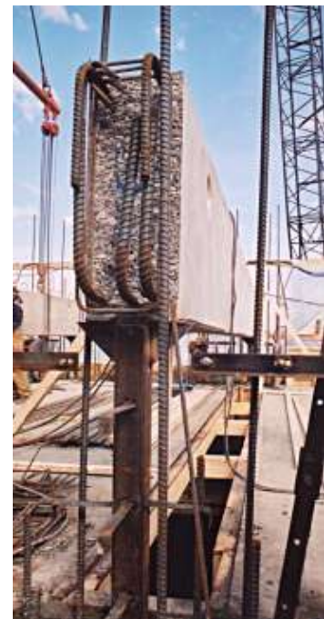
Abb. 62 Stahlbetonbalken als Einbauelement [2.57]
