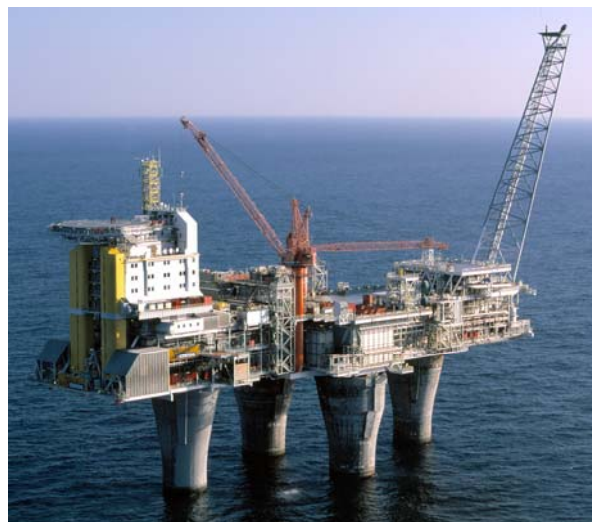
Abb. 6 Bohrplattforminsel Troll A [2.47]
