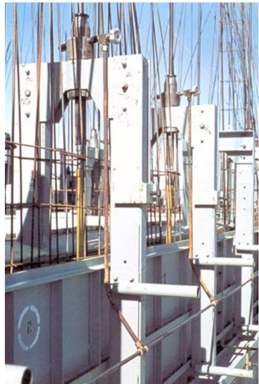
Abb. 28 Gleitbock mit gedoppeltem Jochträger aus U-Profilen [2.39]
