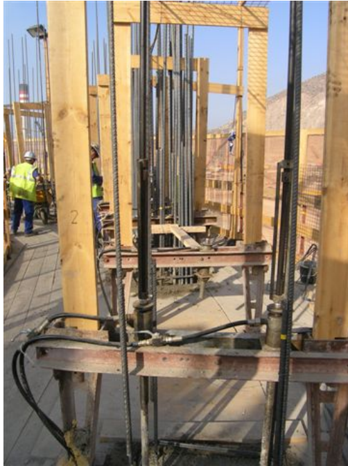
Abb. 43 Zwei Kletterstangen pro Gleitbock im Fall von zu dicken Wänden [2.59]
