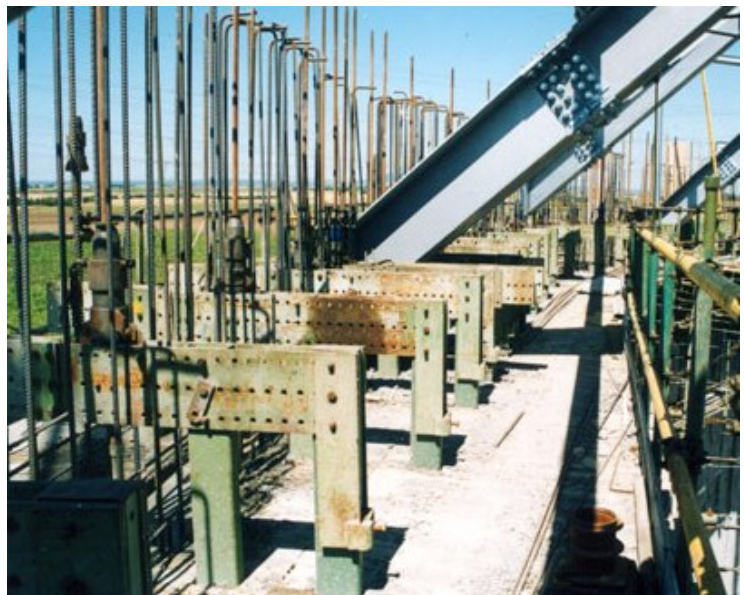
Abb. 31 Gleitbock mit lochgerasterter Jochträger [2.37]
