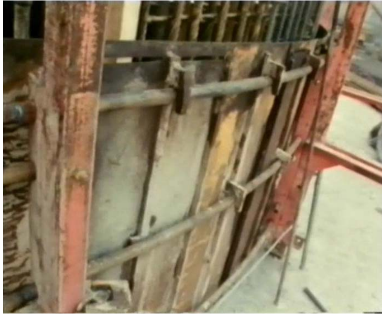
Abb. 48 Stahlblechtafeln einer konischen GS [2.1]
