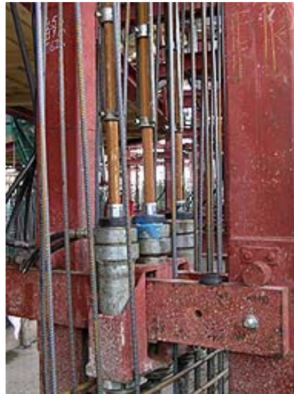
Abb. 55 Anordnung drei nebeneinander liegenden Klettergeräte zur Hebung schwere Lasten [2.58]
