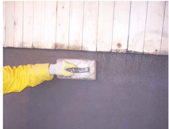
Abb. 46 Filzen der Betonoberfläche nach dem Austritt aus der GS (Eigenfoto)
