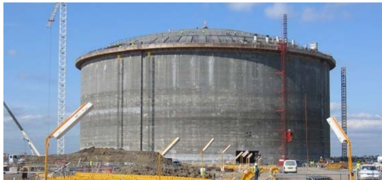
Abb. 10 Der LNG Tank kurz vor Beendigung der Bauarbeiten [2.24]
