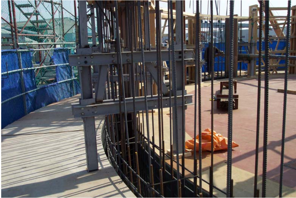
Abb. 28 Gleitbock mit gedoppeltem Jochträger aus U-Profilen [2.39]
