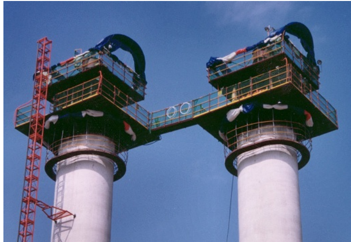
Abb. 41 Verbindung nebeneinander liegender Bauwerke [2.58]
