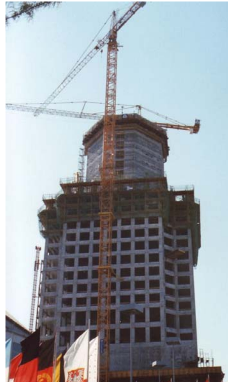
Abb. 3 Der Messeturm in Frankfurt. Gleichzeitige Anwendung von GS und KS [2.48]
