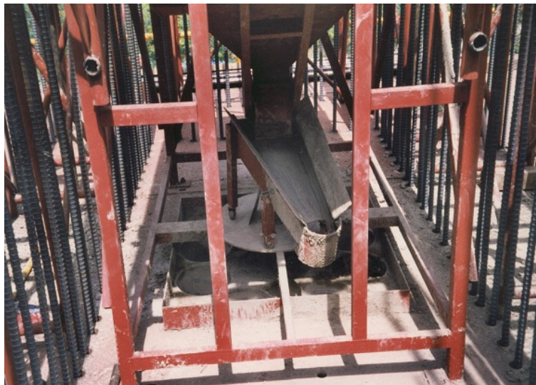
Abb. 54 Trichterbatterie und Verteilerschläuche [2.58]
