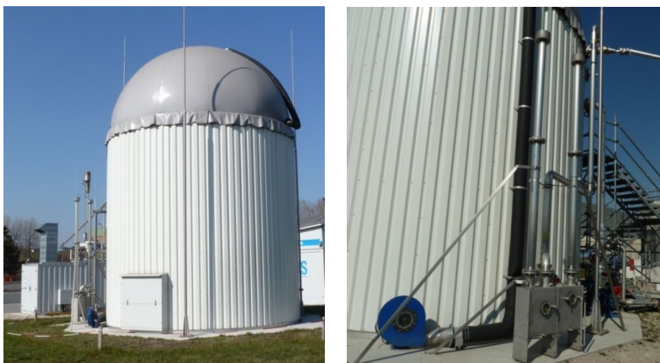
Abbildung 56: Faulbehälter; links: rückwärtige Ansicht mit Abluftschlauch der Stützluft; rechts: Über-/Unterdrucksicherung und Stützluftgebläse (Aufnahmedatum: 11.03.2014)
