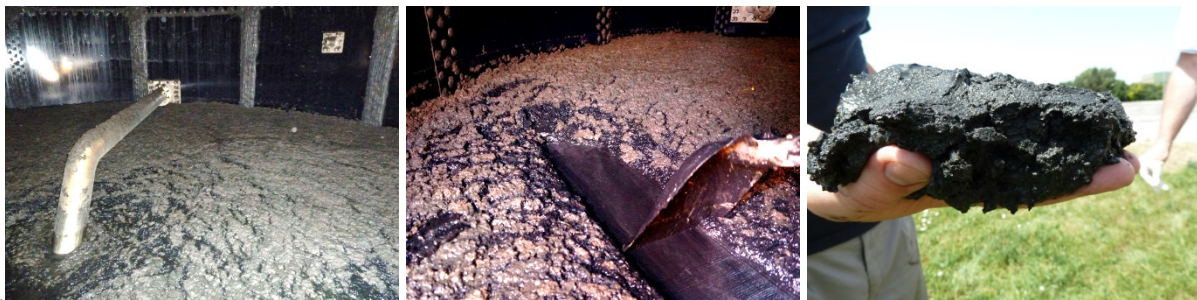
Abbildung 126: Faulbehälter nach Entleerung; links: Innenaufnahme des Faulbehälters; Mitte: Boden des Faulbehälters; rechts: Probe des sedimentierten Materials (Aufnahmedatum: 11.06.2014)
