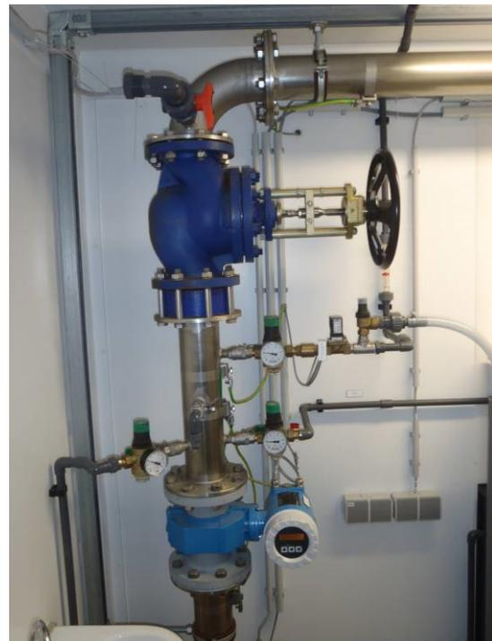
Abbildung 11: Hauptleitung mit Schieber, Druckminderung und Bypassleitungen für Kühlung, Ozon-
