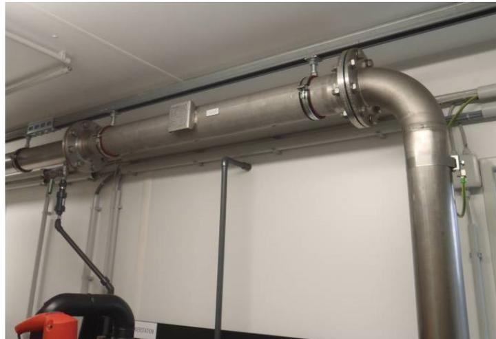
Abbildung 13: Statischer Mischer und Einspeisung von H<sub>2</sub>O<sub>2</sub> in die Hauptleitung
