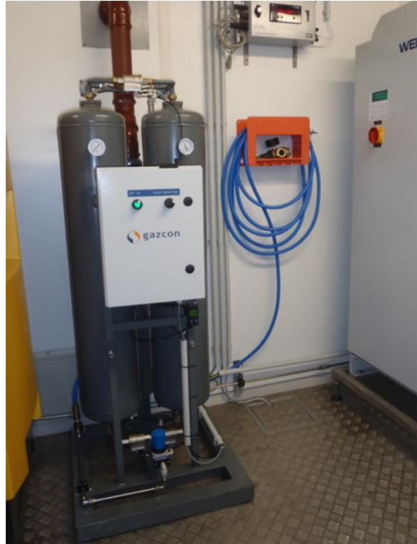
Abbildung 15: Sauerstoffgenerator: PSA-Anlage
