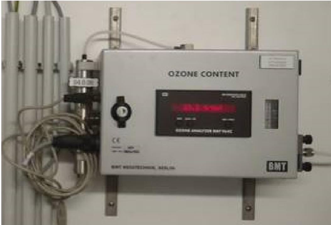
Abbildung 21: BMT-Sonde: Messung der Ozonkonzentration im Gas
