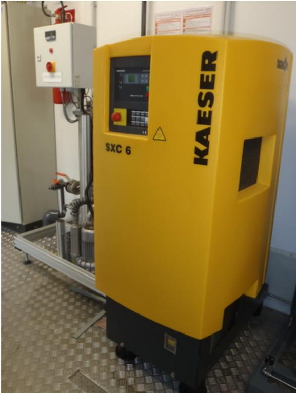
Abbildung 14: Kompressor für O<sub>2</sub>-Erzeugung
