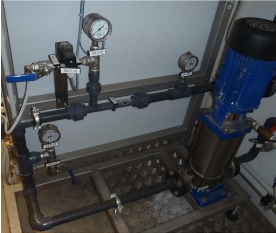
Abbildung 18: Ozoneinspeisung in Bypassleitung, Pumpe und Injektor.
