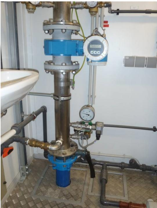
Abbildung 10: Durchflussmesser im Zulauf der Anlage
