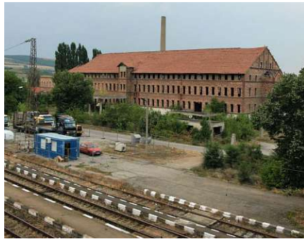
Abb. 94: Bahntrasse und Fabrik
