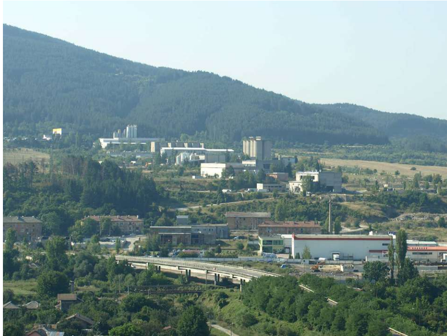
Abb. 6: Batanovci, Blick auf die ehemalige Zementfabrik Granitoid
