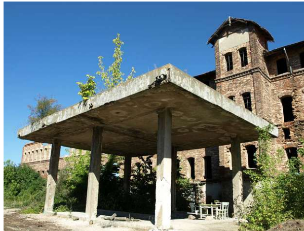
Abb. 28: Ziegelfabrik Struma, Stahlbetonzubau (2019)
