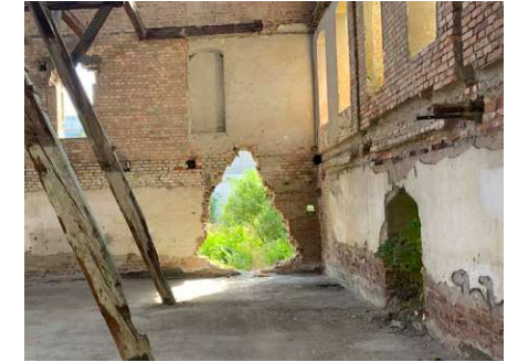
Abb. 71: Mauerwerk-Fehlstellen (2021)
