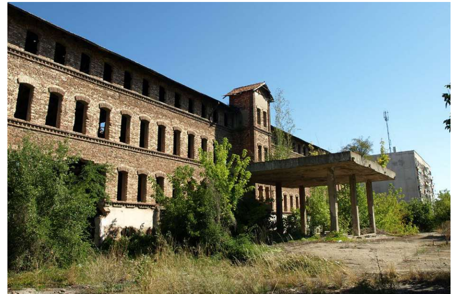
Abb. 57: Südfassade und Stahlbetonzubau aus der Nachnutzungszeit (2019)
