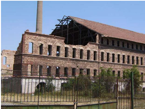
Abb. 27: Ziegelfabrik Struma, Süd-Westfassade (2007)
