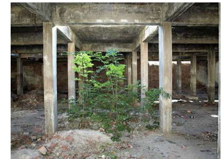
Abb. 75: Einbauten im Westtrakt (2016)
