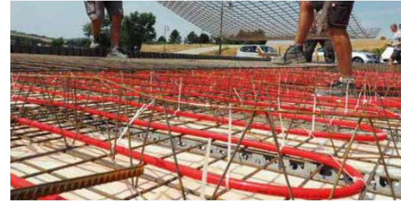
Abb. 104: Verlegung der Heiz- und Kühlregister auf der Deckenbewehrung
