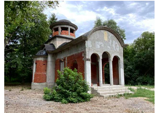
Abb. 10: Kirche - im Bau befindlich
