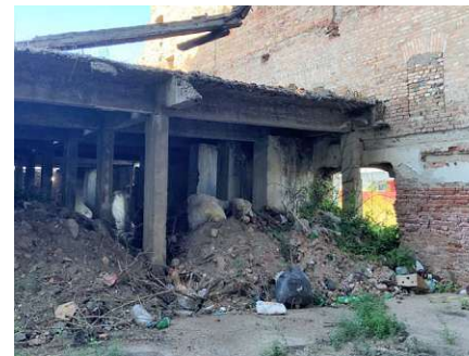
Abb. 74: Einbauten im Westtrakt (2021)
