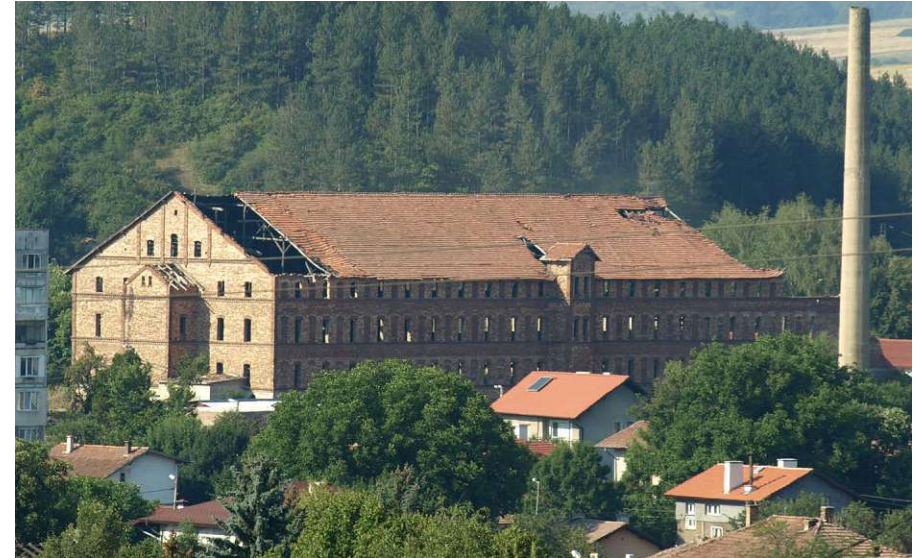
Abb. 56: Nord-Ost-Ansicht mit Schlot vor der Sprengung (2019)
