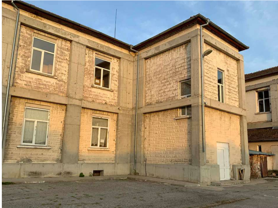
Abb. 76: Schule, Betonverstärkung (2021)
