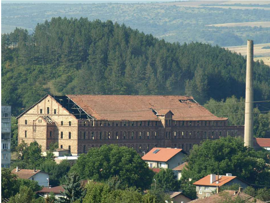
Abb. 25: Ziegelfabrik Struma, Ost-West-Ansicht (2017, Fassade noch intakt)
