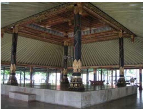
Abb. 34 + 35 Kraton Yogyakarta, das zentrale Viergestell saka guru eines pendopo (Halle), li. pendopo kencana , re. pendopo pagelaran
