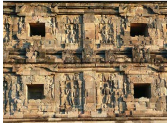
Abb. 208 Candi Plaosan Lor, die Fassadenflächen wurden mit einer Kombination aus tatsächlichen Fenstern, Wandnischen und angedeuteten Nischen rund um die buddh. Figuren gegliedert
