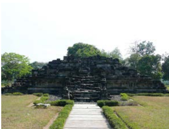
Abb. 318 Candi Bubah, Ansicht Ost, Zugangsseite
