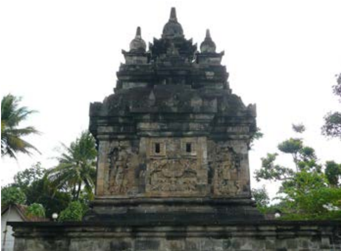
Abb. 95 Candi Pawon, Nordansicht, reich gegliederte Fassaden mit Reliefdarstellungen und kleinen, schmalen Wanddurchbrüchen in die Cella
