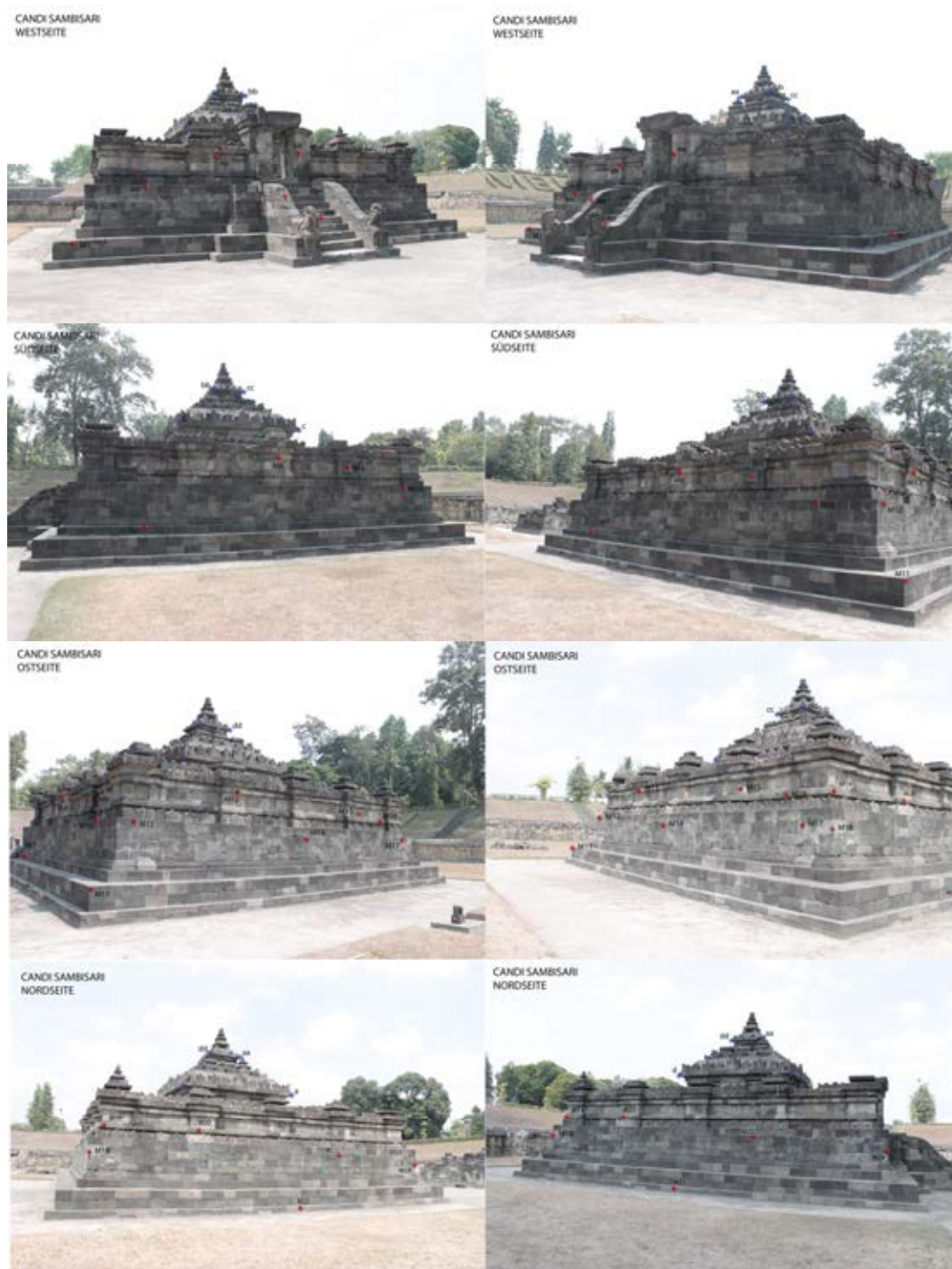
Abb. 370 Candi Sambisari, Foto-Set für die Auswertung per Photogrammetrie; die rot markierten Punkte betreffen messbare Gebäudebereiche, die blauen Punkte nicht messbare Bauteile der Dachzone
