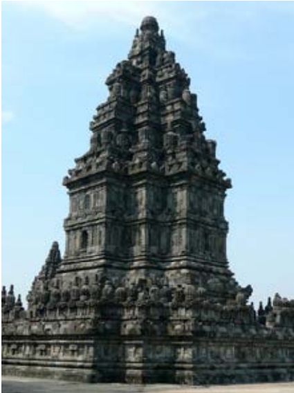
Abb. 93 Candi Garuḍa, Komplex von Prambanan, die zweigeteilte Wandzone sitzt auf einer breiten Sockel-terrasse, starke vertikale Gliederungslinien durch Vor- und Rücksprünge bzw. Abtreppungen (ratha)
