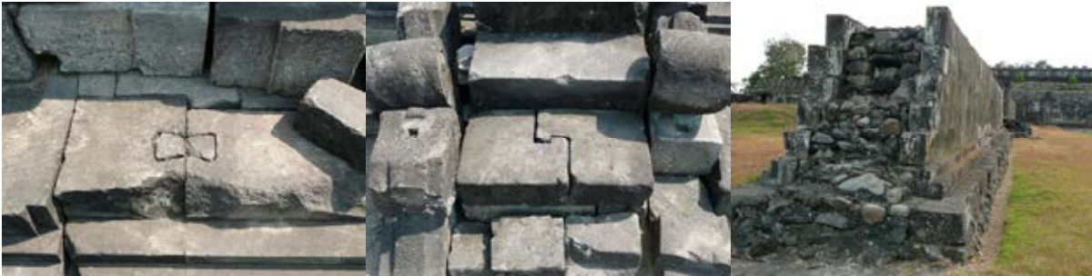
Abb. 45, 46, 47 Fügetechnik beim Trockenmauerwerk mit Keilen (links) und Verzahnungen (Mitte), doppelschaliges Mauerwerk (rechts)
