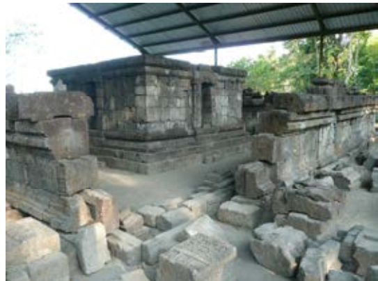
Abb. 350 Candi Kedulan, Schutzbau für den Wiederaufbau des Tempelkörpers und der Umfassungsmauer
