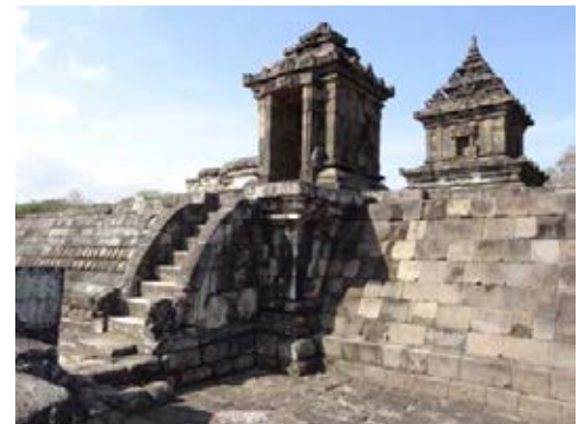
Abb. 111 Candi Barong, Zugang von Westen über einen Portalbau auf die höher gelegene Terrasse der Candi, das Portal war einst Teil einer umlaufenden Mauer und besaß eine hölzerne Tür
