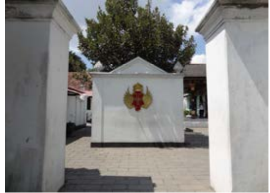
Abb. 109 Kraton Yogyakarta, Durchgangssequenz mit optischer Barriere durch ein zusätzliches, achsial zurück-versetztes Mauerstück, das den Blick nach innen verwehrt
