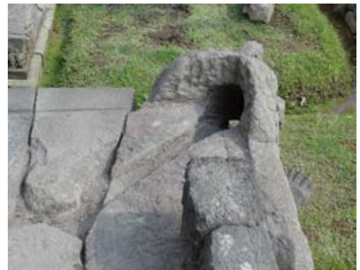
Abb. 165 + 166 links jaladvara an Candi Shiva Prambanan, rechts Candi Ngawen Entwässerungskanal zum jaladvara
