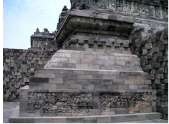
Abb. 264 Candi Borobudur, freigelegter Sockel der ersten Bauphase an der südöstlichen Bauwerksecke
