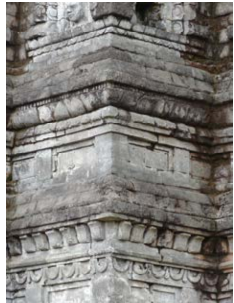
Abb. 218 Candi Bhima, Dieng Plateau, Übergang von Wand- zu Dachzone, vielteiliges Gesims im Wechsel mit Friesen, einzelne Leisten zeigen Zahnschnitt-Motive, Girlanden und Verzierungen mit Lotusblättern
