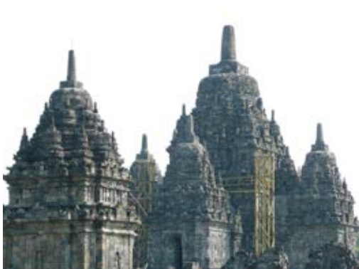
Abb. 196 Candi Sewu, der stūpika als Bauelement bestimmt die Dachzone der Tempel von Candi Sewu
