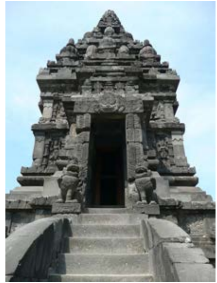
Abb. 92 Candi Apit im Komplex von Loro Jonggrang, Blick vom Antritt der Treppe zur Dachstruktur, das sich stark verjüngende Dach erzeugt zusätzliche Höhe
