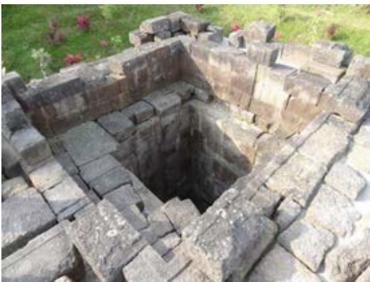
Abb. 362 Candi Pendem Sengi, pripih-Grube im Sockel unter dem Cella-Boden
