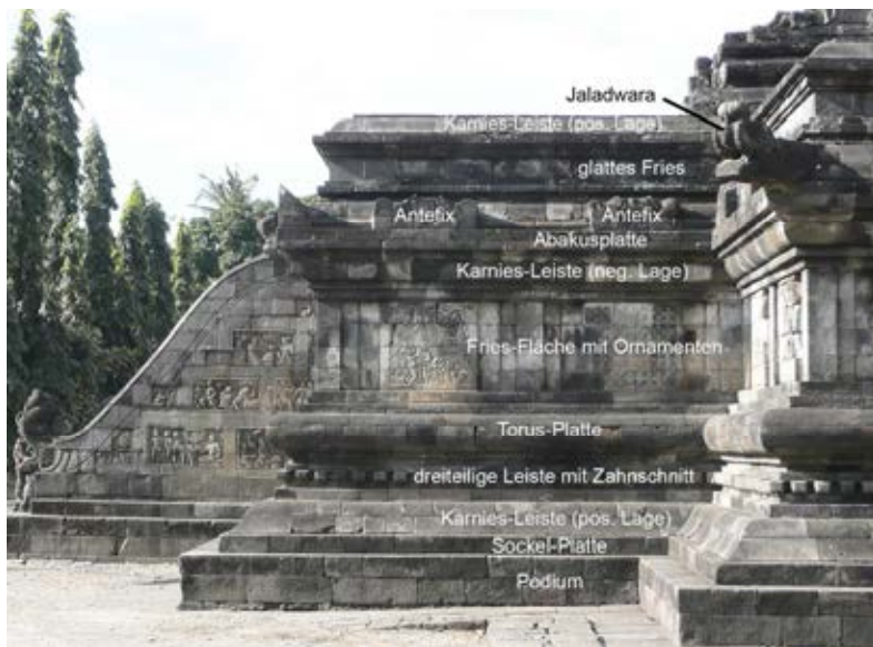
Abb. 216 Candi Mendut, Erklärung der Bestandteile eines Gesims in Kombination mit Friesen
