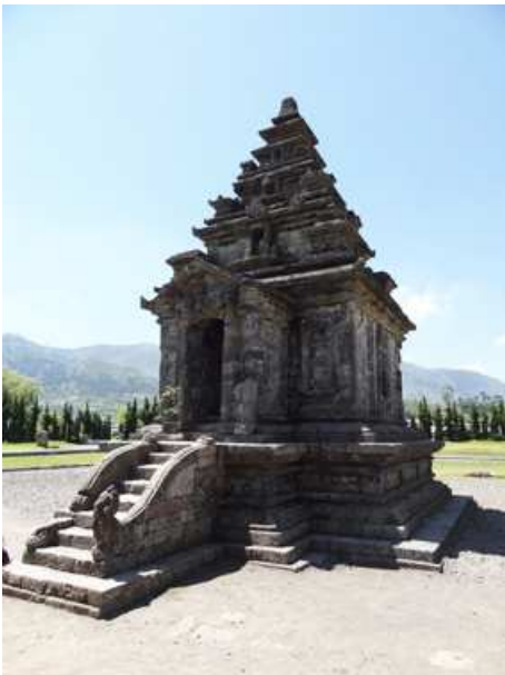
Abb. 240 Dieng Plateau, Candi Arjuna, Südwest, Aufnahme 2011 nach Fertigstellung der Restaurierung
