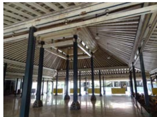
Abb. 34 + 35 Kraton Yogyakarta, das zentrale Viergestell saka guru eines pendopo (Halle), li. pendopo kencana , re. pendopo pagelaran
