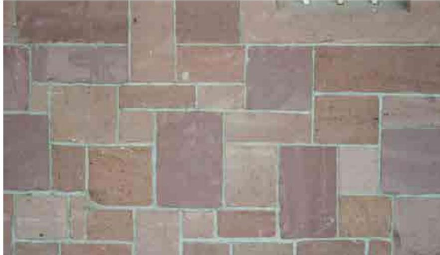
Abb. 302: Detailansicht der Sockelzone auf der Geschossebene des Stückgutschuppens aus roten Sandsteinverblendungen, 2022
