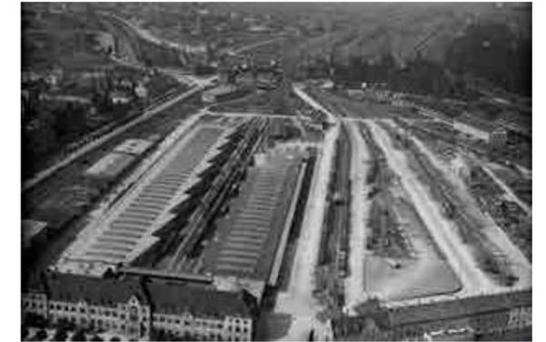
Abb. 21: Luftaufnahme des Güterbahnhofes in Basel mit sägeförmiger Gleisanordnung, o.J.
