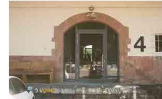
Abb. 185: Ansicht des rundbogenförmigen Ladetores mit eingebauter Fixverglasung samt Tür auf der Süd-West-Fassade des Eilgutschuppens, 2022
