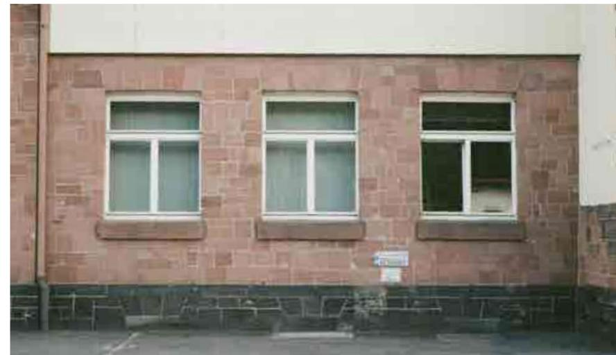
Abb. 293: Fassadenansicht des Erdgeschosses des südlichen Gebäudetraktes der Güterabfertigung mit Sandsteinverblendungen und der Sockelzone, 2022
