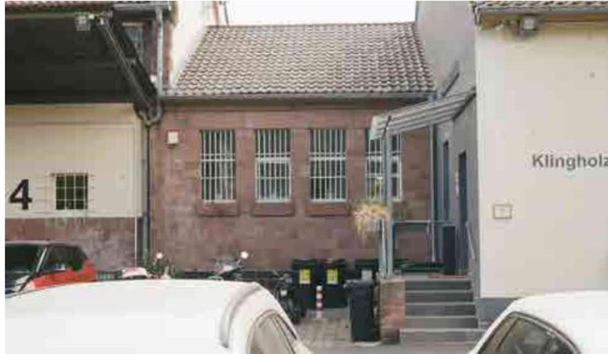
Abb. 286: Ansicht des nördlichen, eingeschossigen Gebäudetraktes der Güterabfertigung mit der ursprünglichen Sandsteinverblendung und den vier Fensteröffnungen, 2022
