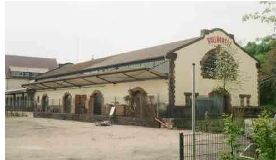
Abb. 316: Ansicht des Eilgutschuppens mit seiner vier Ladetoren auf der Nord-Ost-Seite und der Kopffassade mit dem markanten Segmentbogenfenster, 2022
