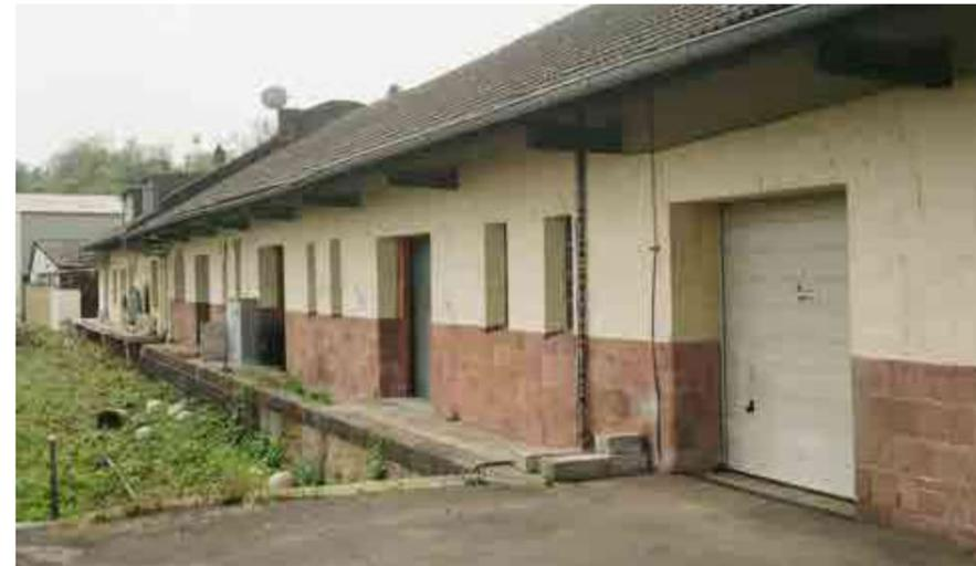
Abb. 329: Ansicht der Nord-Ost-Fassade des Zollschuppens mit seinen veränderten Ladetoren, 2022
