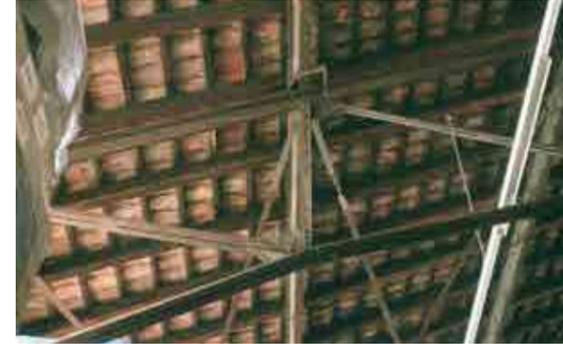
Abb. 189: Detailsansicht der Konstruktionsweise eines eisernen Fachwerkträgers im Inneren des Stückgutshuppens, 2022
