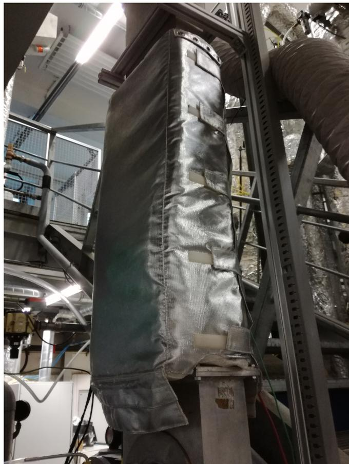
Abbildung 4.6: Heizmantel angebracht am vertikalen Rohgaskanal
