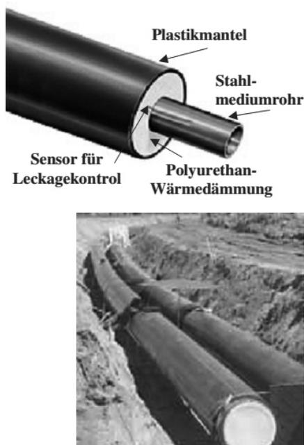
Abbildung 3.13: Verlegung einer Fernwärmeleitung (vgl. Konstantin 2007, S. 371).
