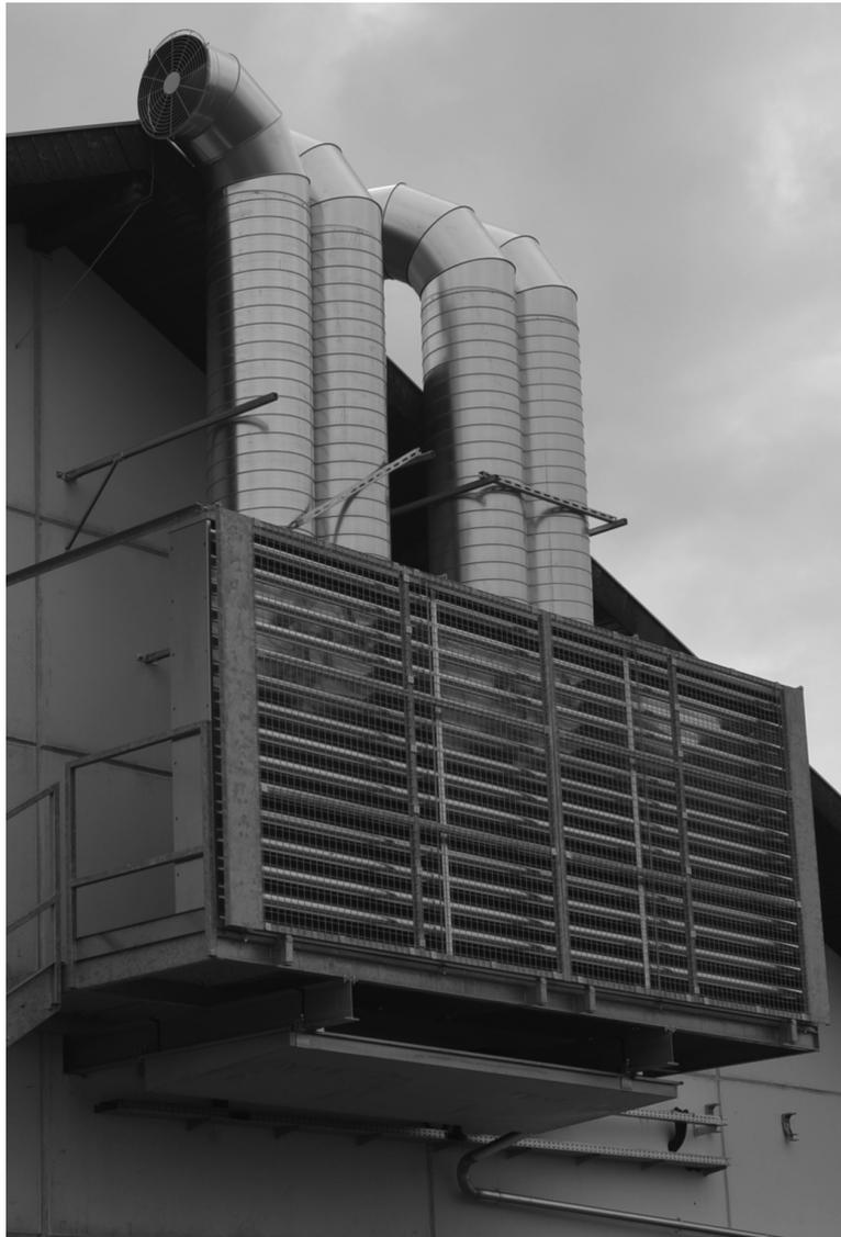
Abbildung 5.3: Wärmepumpe Außeneinheiten
