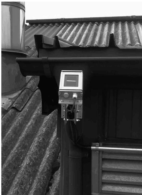
Abbildung 5.7: Montage Einstrahlungssensor
