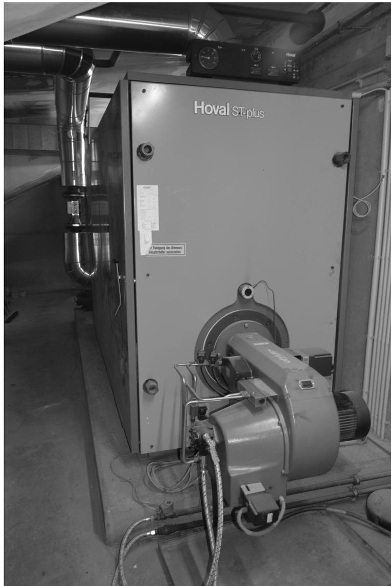
Abbildung 4.3: Spitzenlastkessel mit Brenner (eigene Aufnahme)
