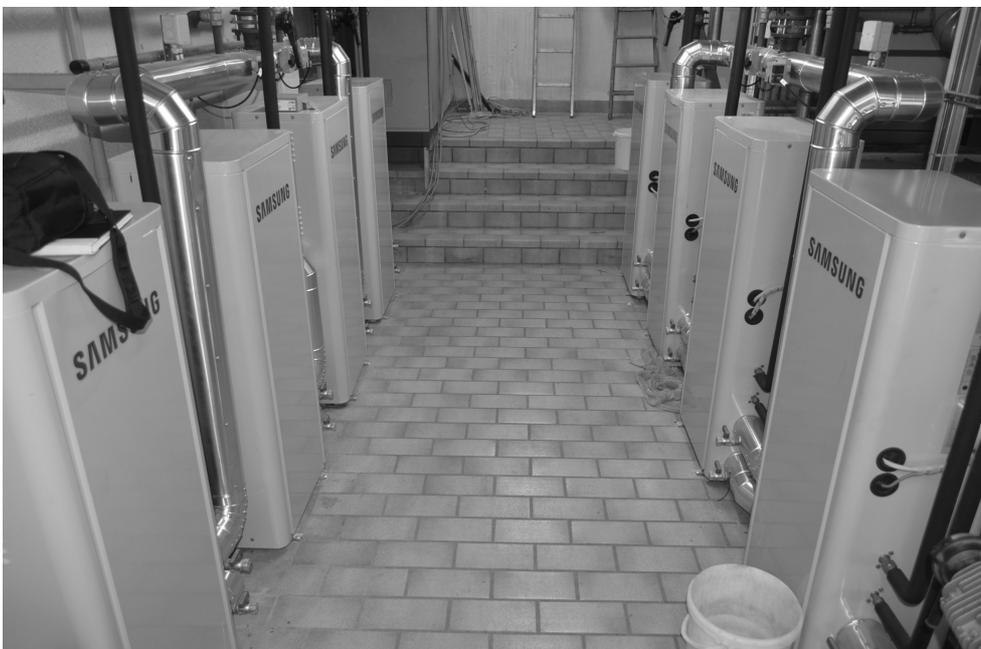
Abbildung 5.2: Wärmepumpe Inneneinheiten
