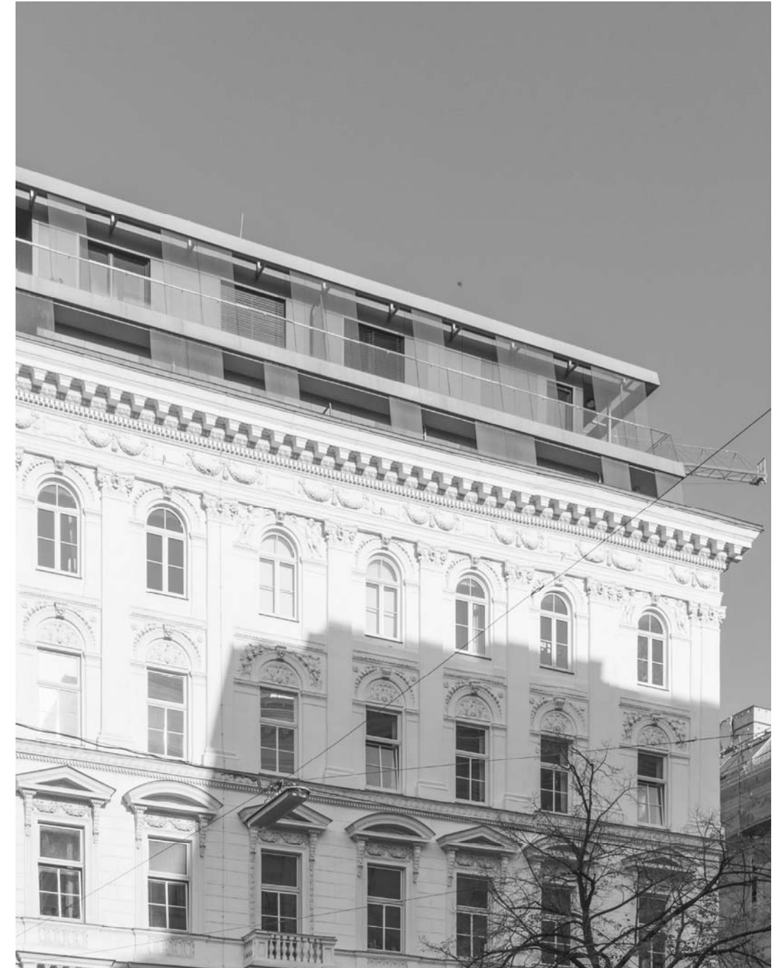
Abb. 31 Börsegasse 10 Dachausbau Fotoaufnahme
