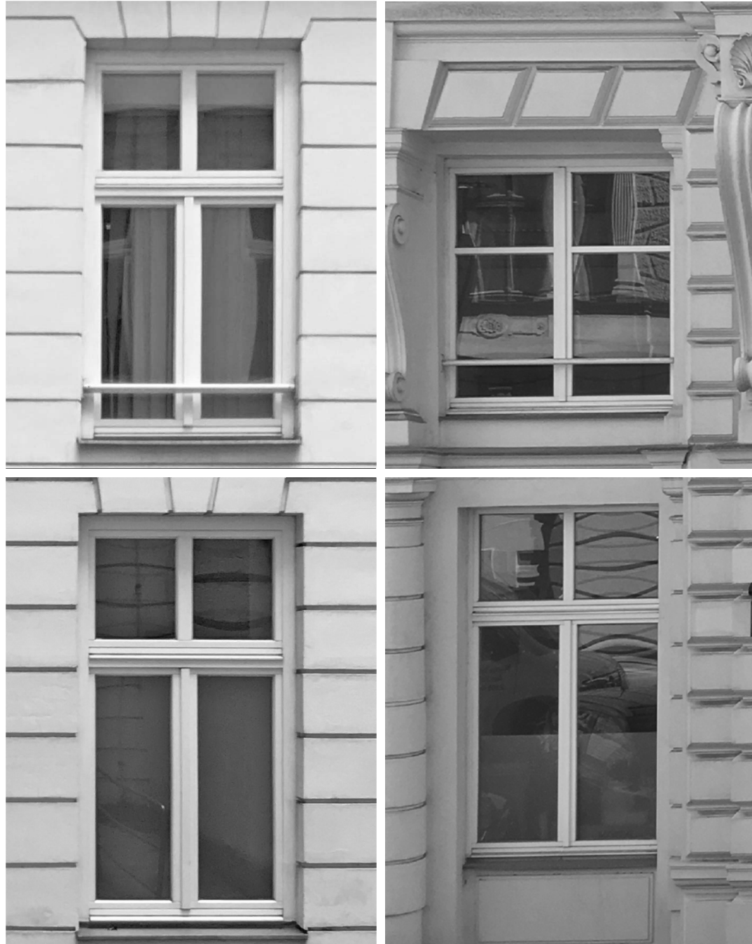
Abb. 18 bis 21 Aussenaufnahmen 2017, Fenster Parterre und Mezzanin links Hofseitig, rechts Strassenseitig
