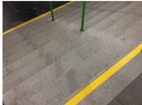
(b) Stufenmarkierung mit gutem Farbkontrast
