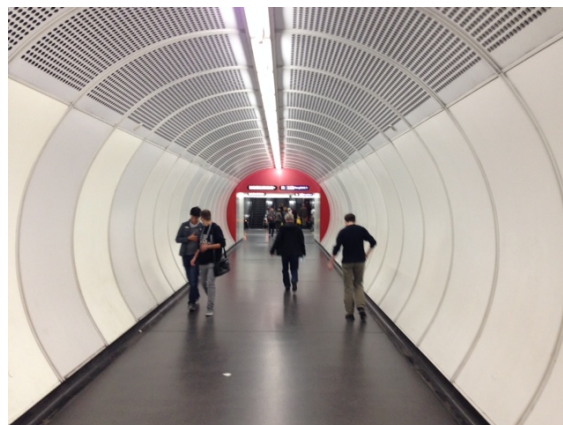
(b) Lichtleisten längs zur Gehrichtung angeordnet \Rightarrow reduzierte Blendung, sehr guter Helligkeitseindruck
