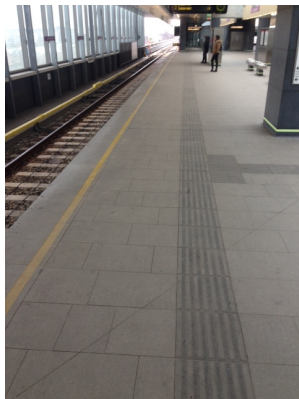
(a) Gefräste Bodenmarkierungen mit geringem Kontrast
