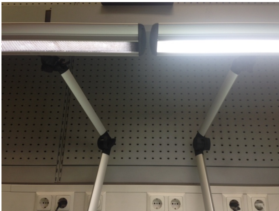
Abbildung 123: Arbeitsplatzleuchte „Taneo“ der fa. Waldmann links: mit TSB-Entblendung; rechts: mit Original-Entblendung
