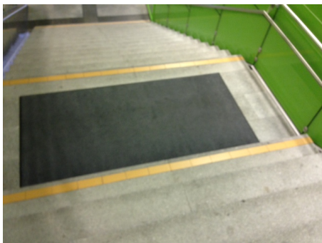
(a) Stufenmarkierung mit Podestkontrast
