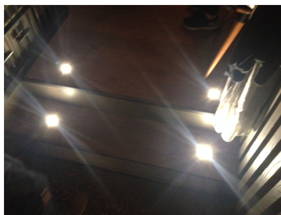
(b) Einbauleuchten in Trittstufen
