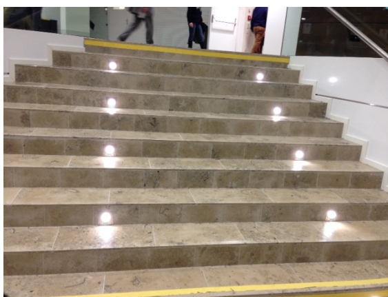
(a) Einbauleuchten in Setzstufen
