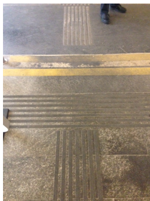
(c) stark verschmutzte und abgetragene Markierungen
