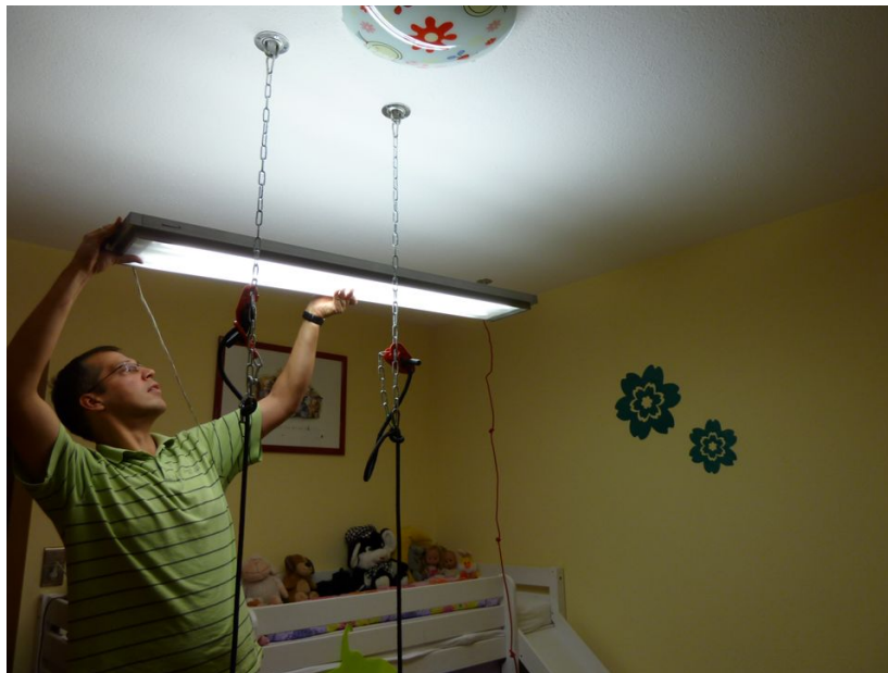
Abbildung 44: Erprobung einer Pendelleuchte vor Ort
