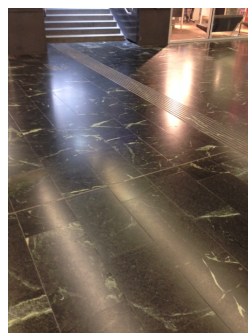
(b) Reflexblendung auf schwarzem Glanzboden am Bahnhof Wien-Praterstern
