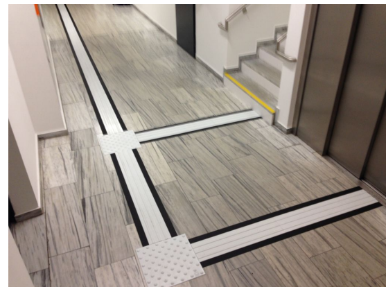
(d) Bodenmarkierung mit Kontraststreifen zur Kontrasterhöhung
