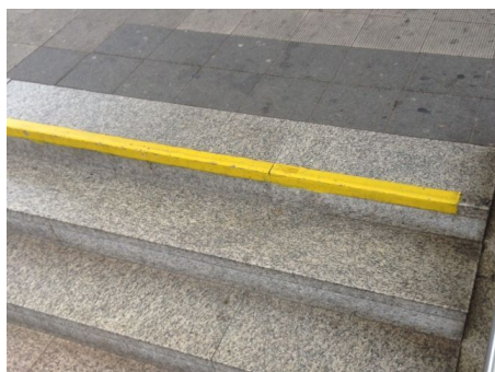
(c) Tritt- und Setzstufenmarkierung
