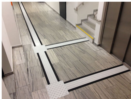
(a) Taktiles Bodenleitsystem mit Kontraststreifen
