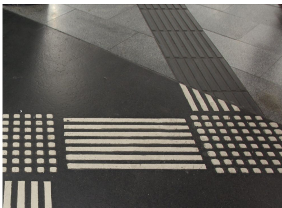
(c) Bodenmarkierungen unterschiedlicher Breiten mit unterschiedlichem Kontrast
