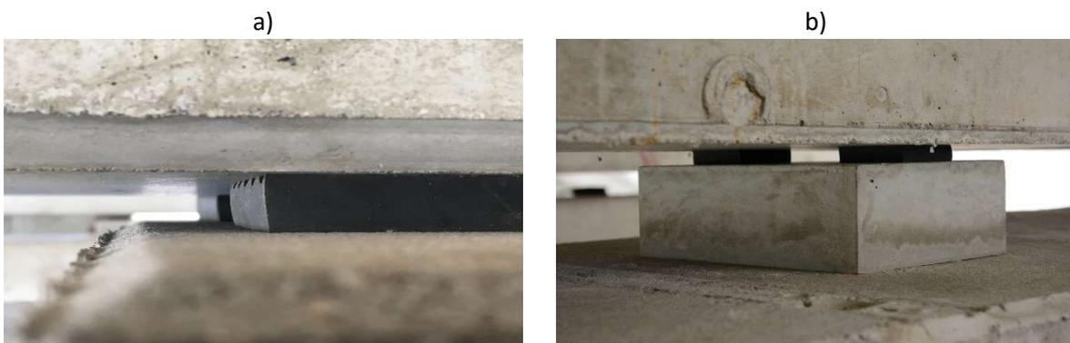
Bild 3.19/a: Elastomerlager
