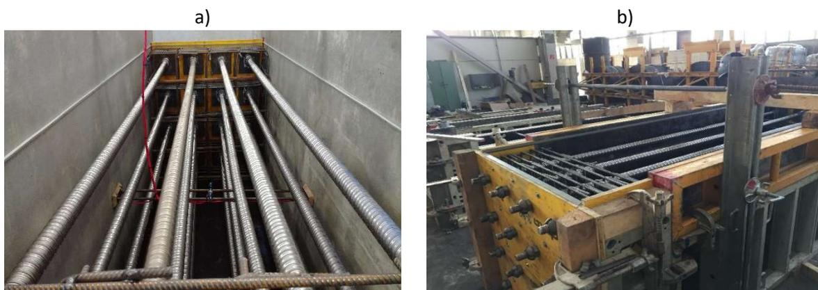
*Bild 3.13/a und 3.13/b: großer Körper (mit 1000x1000 [mm] Querschnitt) vor der Betonierung; Serie S4*
