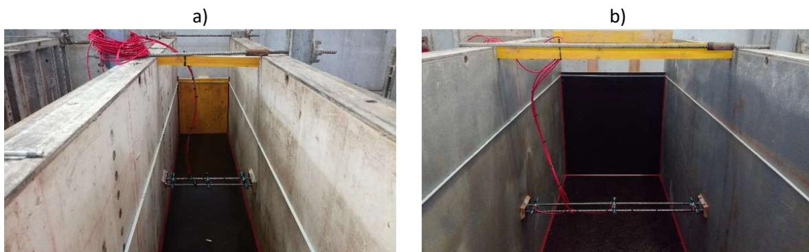
*Bild 3.6/a: mittlerer Körper (mit 500x500 [mm] Querschnitt) der Serie S3 vor der Betonierung
