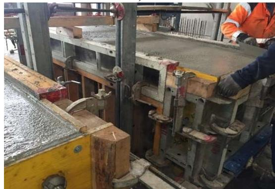
Foto 4: Betonierung
