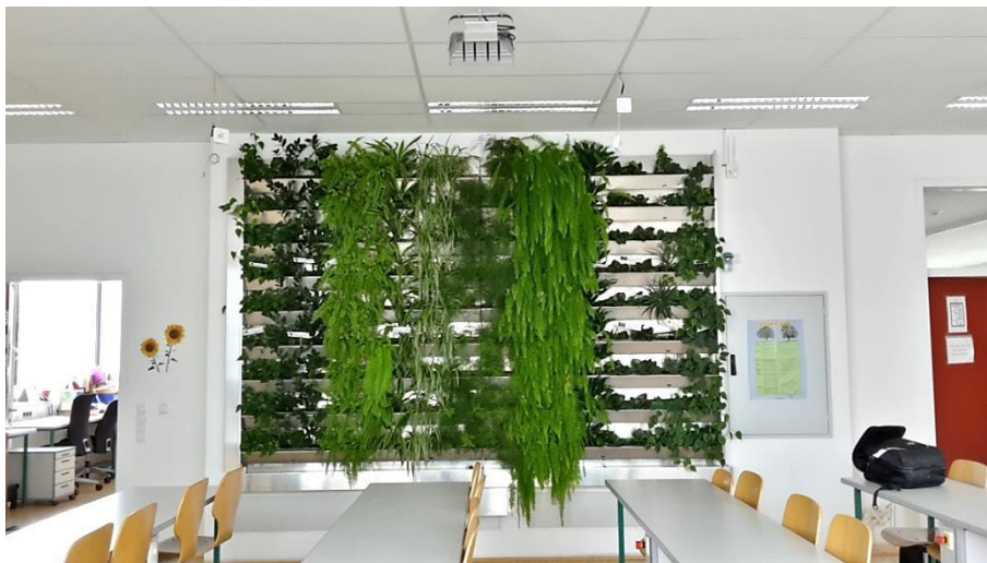
Abb. 2.2: Trogsystem im Biologiesaal Raum 255. Es sind insgesamt neun Tröge, übereinander mit einem regelmäßigen Abstand zueinander, an der Innenwand parallel zur Fensterfront angebracht. Die von der Firma bevorzugte LED-Beleuchtung ist oben im Bild gut zu erkennen. Die Sensoren (von links nach rechts) RTR671 (blau), 11452 (weiß), und 11494 (weiß) sind zwischen der Beleuchtung und Grünwand angeordnet.
