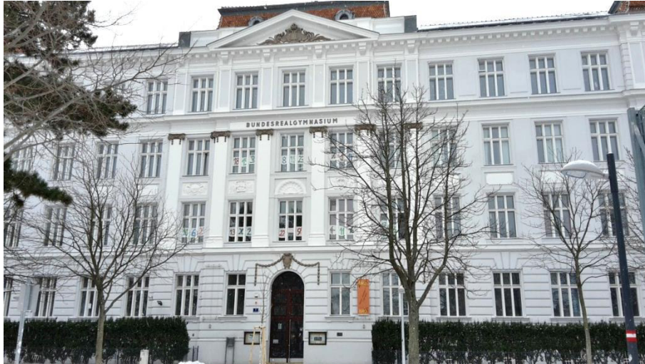
Abb. 2.8: Außenansicht des Haupteingangs des BRG 16. Die am Projekt beteiligten Räume befinden sich hinter dem sanierten Hauptgebäude im neu errichteten Anbau.
