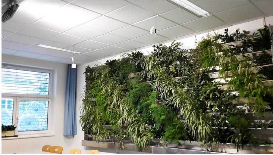
Abb. 2.9: Trogssystem im Biologesaal Raum N.004. Es sind insgesamt acht Tröge, übereinander mit einem regelmäßigen Abstand zueinander, an der Innenwand parallel zur Fensterfront angebracht. Die LED-Beleuchtung ist oben rechts im Bild gut zu erkennen. Die Sensoren (von links nach rechts) 11411 (weiß), 11487 (weiß), und RTR 665 (blau) sind zwischen der Beleuchtung und Grünwand angeordnet.
