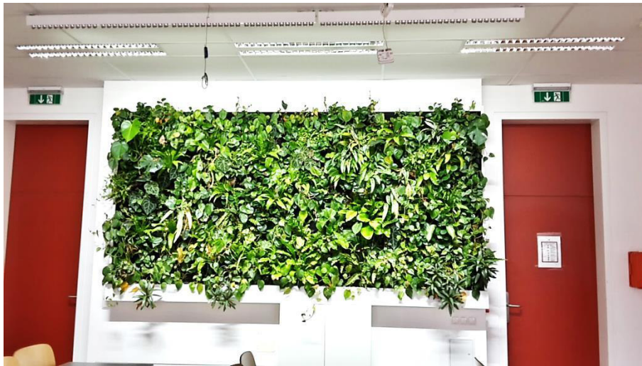
Abb. 2.6: Vliestaschensystem im Physiksaal Raum 251. Auch hier befindet sich der Aufbau an der Innenwand gegenüber von der Fensterfront. Die LED-Beleuchtungsleiste ist zwischen den Messsensoren angebracht. Die laut Grundriss betriebenen Sensoren sind (von links nach rechts) 11667 (weiß), RTR 679 (blau) und 11714 (weiß).
