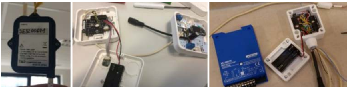
Abbildung 16 verwendete Messtechnik im Innenraum; links ein RTRs - Messsensor und der Aufbau der Messsensorik auf den zwei Bildern rechts. (eigene Fotos)
