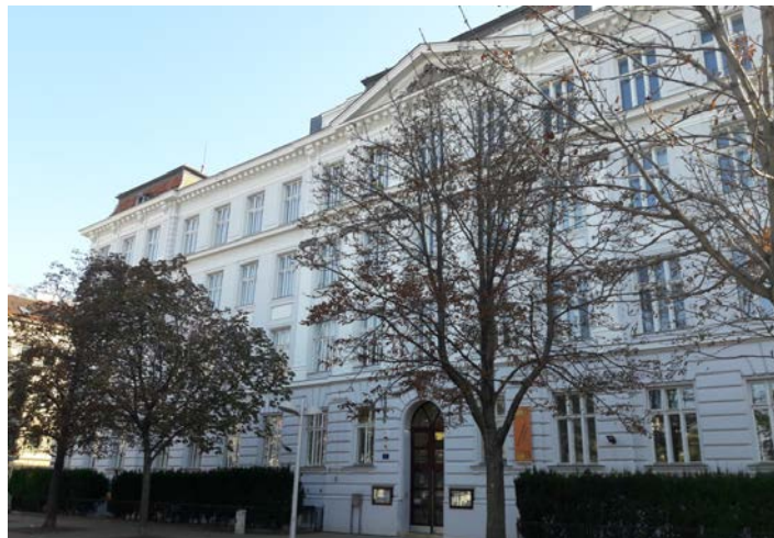
Abbildung 13 Ansicht des BRG 16 Gebäudes, Neubau ohne Lüftungsanlage am Schuhmeierplatz 7, 1160 Wien (eigenes Foto)
