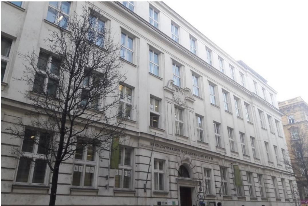
Abbildung 7 Ansicht des GRG 7 Gebäudes, Altbau ohne Lüftungsanlage in der Kandlgasse 39, 1070 Wien (eigenes Foto)
