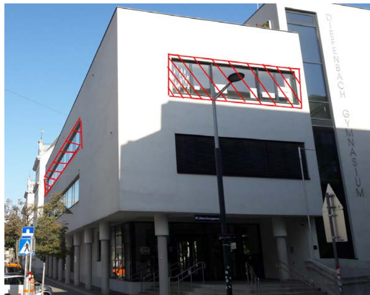
Abbildung 10 Ansicht des BRG 15 Gebäudes, Neubau mit Lüftungsanlage in der Diefenbachgasse 19, 1150 Wien. Des Weiteren sind die in Rot gekennzeichneten Bereiche die Fensterfronten der untersuchten Klassenzimmer. Dabei ist zu beachten, dass der vordere Klassenraum (der Biologieraum) über dem Eingang der Schule liegt und in der Nachmittagszeit direkter Sonneneinstrahlung ausgesetzt ist. Somit ist dieser Raum wärmer als die beiden anderen Räume, worauf in der späteren Auswertung nochmals näher eingegangen wird. (eigenes Foto)
