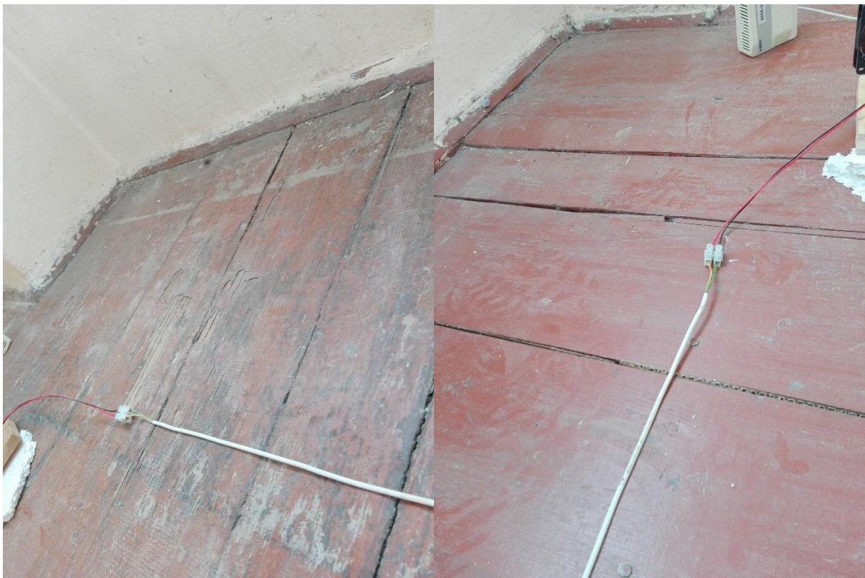
Abb. A.12: Vergleich der Dielenfugen auf der linken und rechten Seite der Senke
