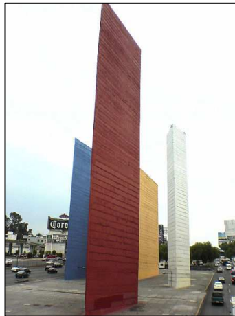
Abbildung 44: Satellite City Towers, Mexiko-City, 1957
