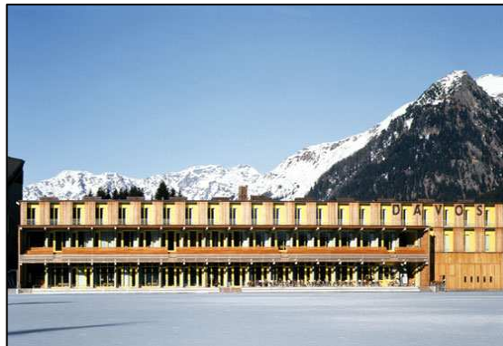
Abbildung 88: Davos/Schweiz, Sportzentrum. Architekturbüro Gigon/Guyer, künstlerische Mitarbeit: Adrian Schiess. Überarbeitung, Planung und Ausführung: 1992 bis 1996. 420
