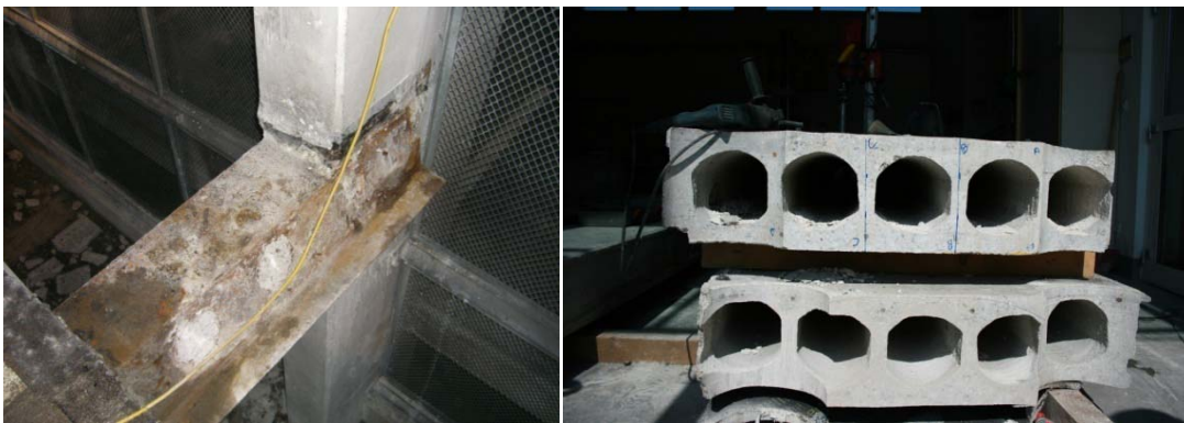
Abbildung 8.2: Ansicht der einzelnen Elemente; Deltaträger (links), Hohldiele (rechts)
