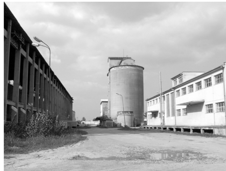
Abb.10. Das Zementsilo in der Mitte, links die bereits assanierte Produktionshalle von 1929
