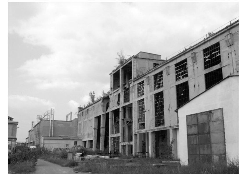
Abb.11. einige der im Jahr 1995 assanierten Objekte
