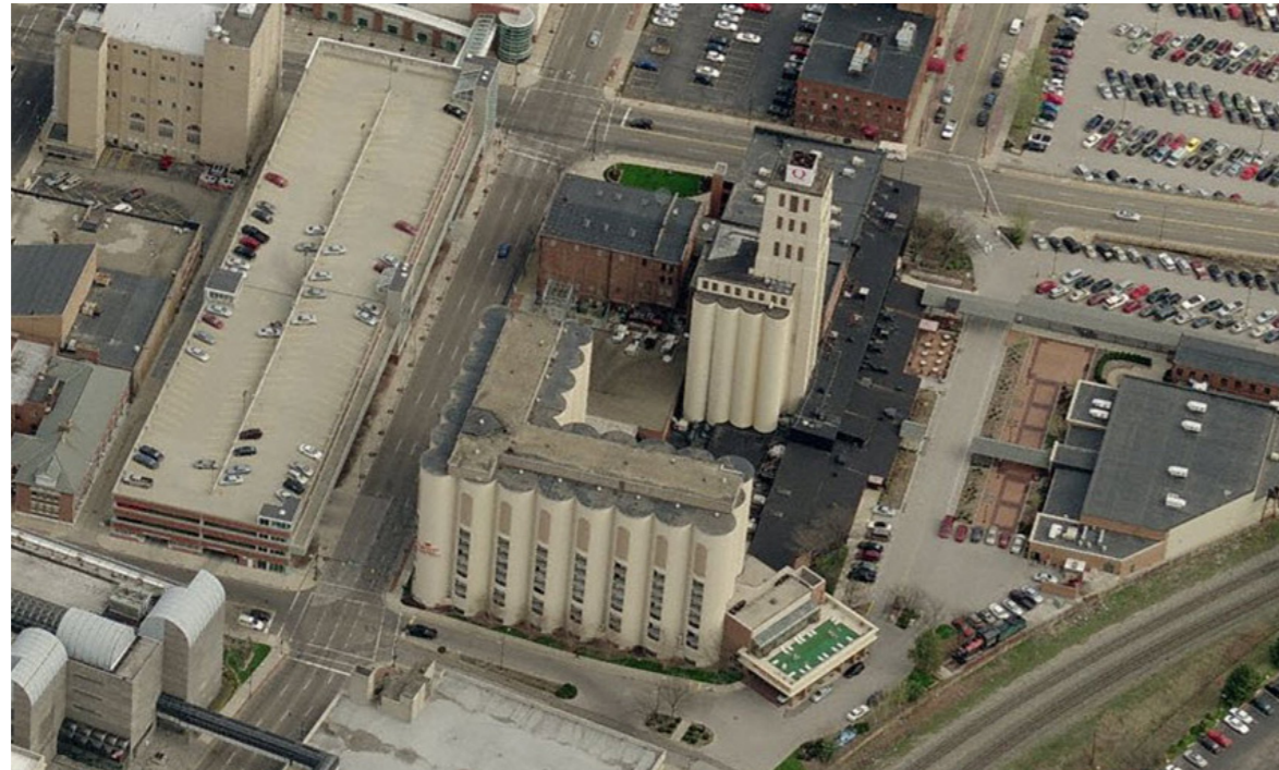
Abb.26. Blick auf das Gelände des Quaker Square Inn
