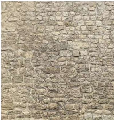
Bruchsteinmauerwerk
