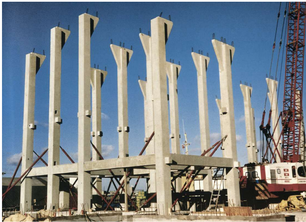
Abb.24 DER STÜTZENWALD ENTSTEHT, Baustelle Kopenhagen, 1985
