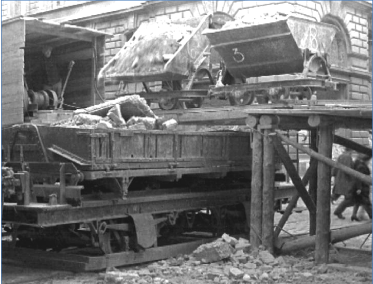
Abbildung 5: Beladung von Waggons der Wiener Straßenbahn mit Bauschutt
