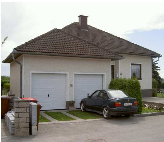
Abb. 24: Bungalow vor der Sanierung
