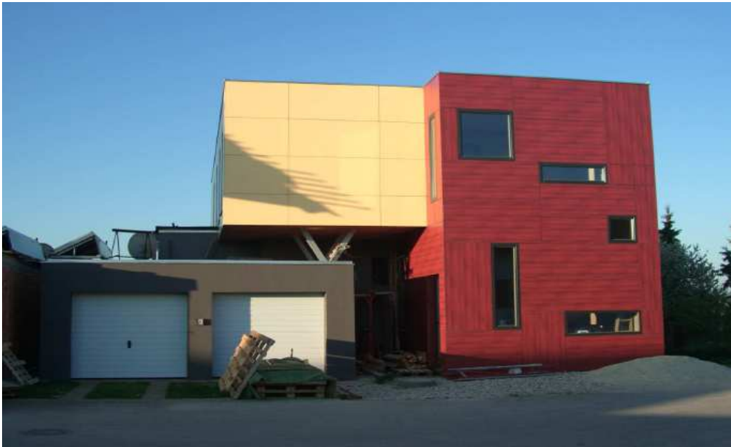
Abb. 26: Zweifamilienhaus am Ende der Baustelle (Nordfassade), die Wohnung der Aufstockung (hell gelb), das Stiegenhaus (rot)
