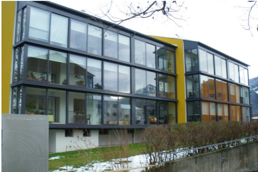
Abb. 18: ein Gebäude der WHA, nach der Sanierung
