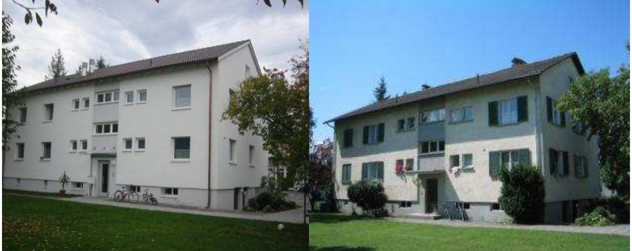
Abb. 12: Objekt A, vor der Sanierung (l.), nachher (r.)
