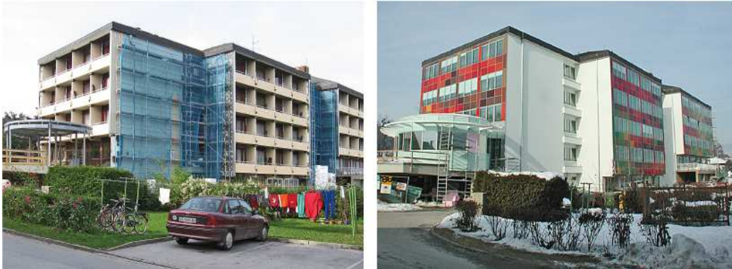
Abb. 29: Objekt G während der Sanierung (l.), nach der Sanierung (r.)
