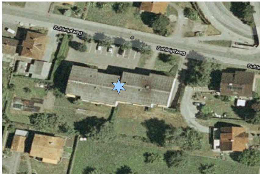
Abb. 15: das zum Passivhausstandard sanierte Objekt C (Blaue Stern); GoogleMaps©
