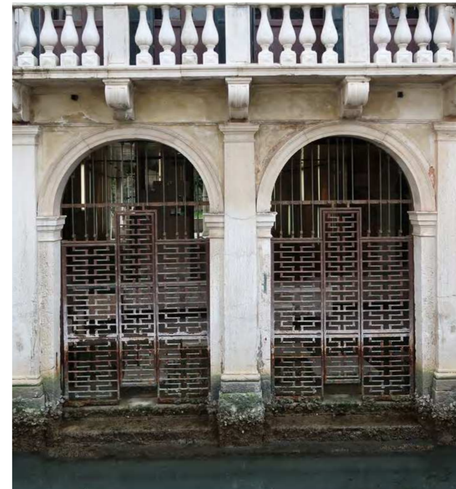
Gondel-Einfahrt aus Metall in einfacher und archaischer Ausführung als Anlehnung an Burgen und die historische Bausubstanz.
