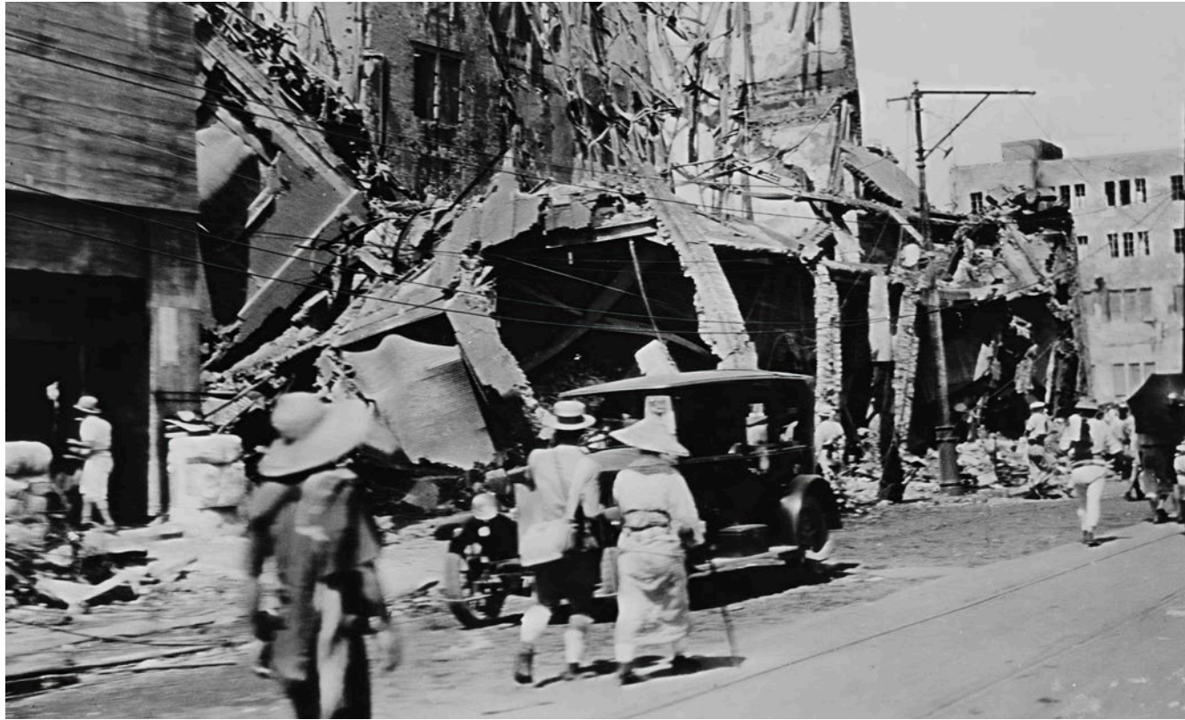
Abb. 97 - zerstörte Gebäude nach dem großen Kanto Erdbeben 1923 Quelle: Hulton Archive - Evans - www.gettyimages.de
