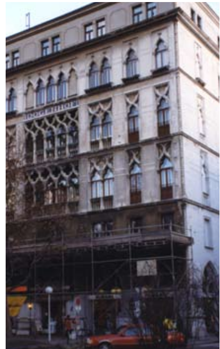
Abb. 5.63 (K46): Dogenhof mit Schutzgerüst
