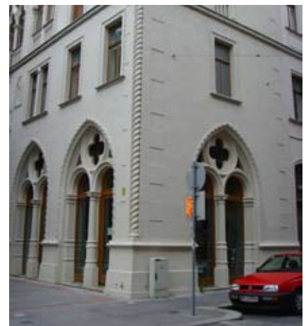
Abb. 5.77: Wiederhergestellte Mittelsäulen im Parterre
