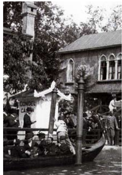
Abb. 4.24-25: Gondelfahren in Venedig in Wien
