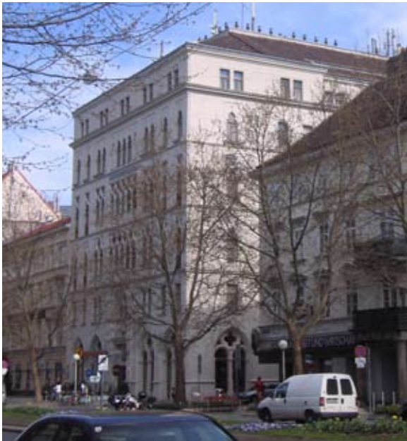
Foto nach der Restaurierung
