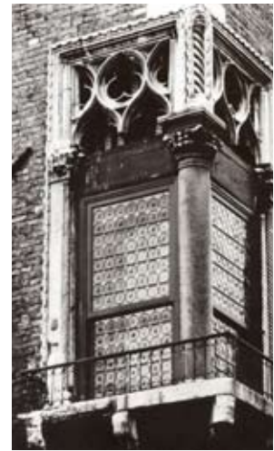
Abb. 4.49: Venedig: Palazzo Priuli, Eckbalkon
