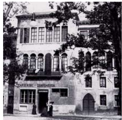
Abb. 4.26: Erste Palastfronten nach dem Haupteingang zu Venedig in Wien
