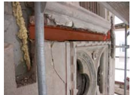
Abb. 5.75-76: Alte und neue Träger
