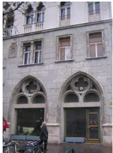
Abb. 5.69: Öffnungen im Parterre mit eingebautem Sturz
