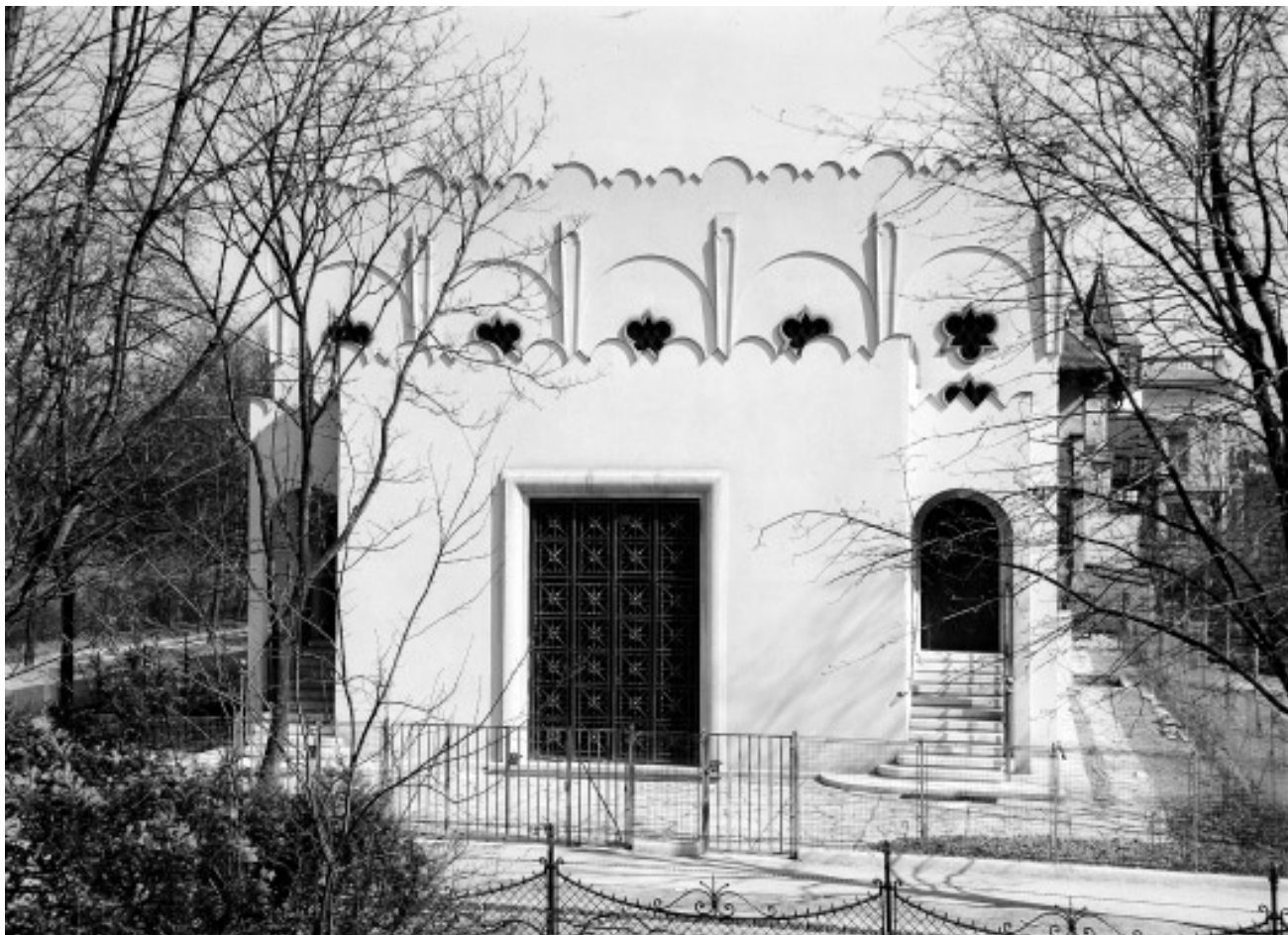
Abb.62 Frontalansicht der Westfassade
