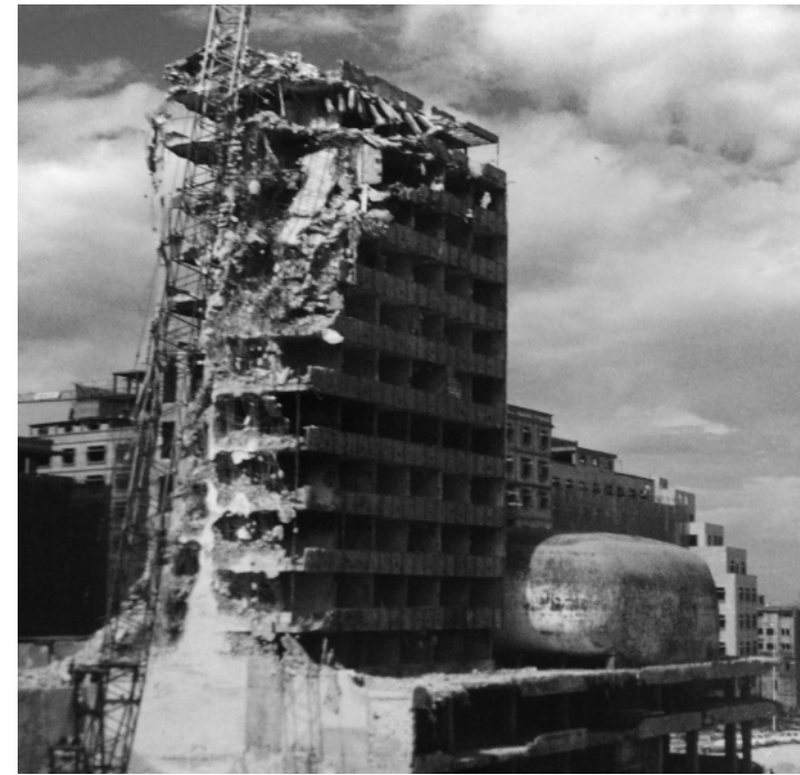
Das Gebäude mit dem durch den Bürgerkrieg zerstörten Büroturm, der nach Ende des Krieges aus statischen Gründen abgerissen werden musste.
