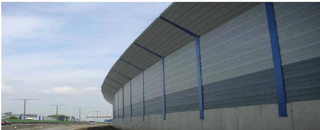
Abbildung 48: Beispiel für eine geknickte Lärmschutzwand–A23 Südosttangente Wien [32]
