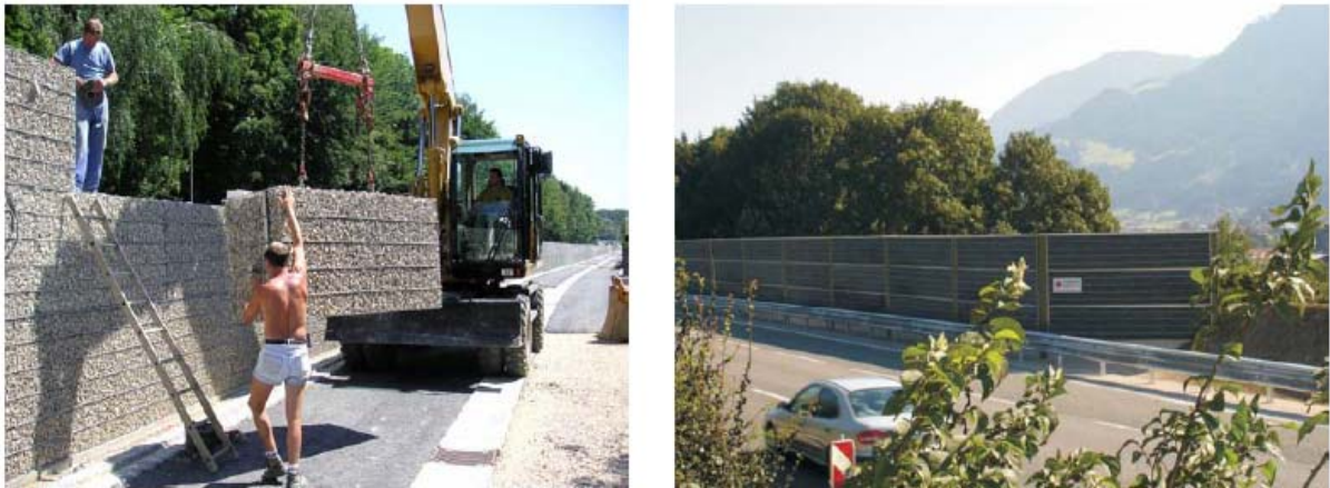
Abbildung 43: Lärmschutzwände mit gefüllten Körben [32]
