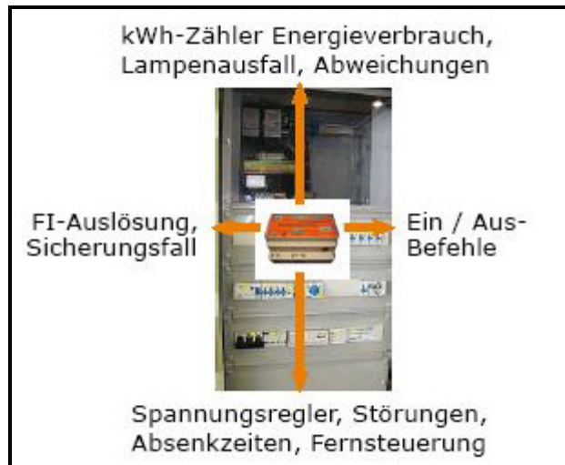
Abbildung 3: Das Communication Center in einem Verteilerkasten
