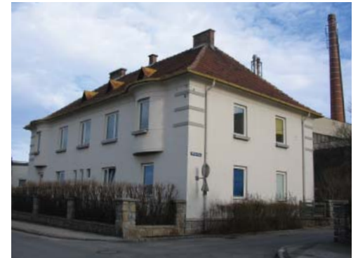
Abb. 3.7.3.9. Krankenhaus und Spi- talwäscherei, 1921 Weitrarer Straße 115 3950 Gmünd
