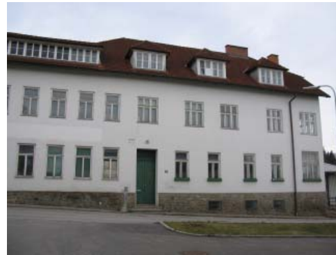
Abb. 3.7.3.2. Strick- und Wirkwarenfabrik Knopp, 1904 Bahnhofstraße 8 3874 Litschau
