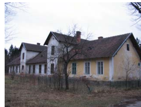
Abb. 3.5.1.9. Arbeiterhäuser Nr. 6 u. 7
