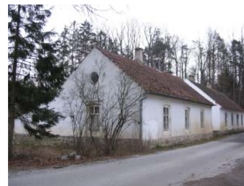
Abb. 3.5.1.8. Arbeiterhäuser Nr. 4 u. 5
