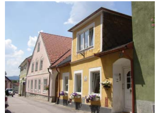
Abb. 5.3.2. Bürgerhäuser Lange Gasse
