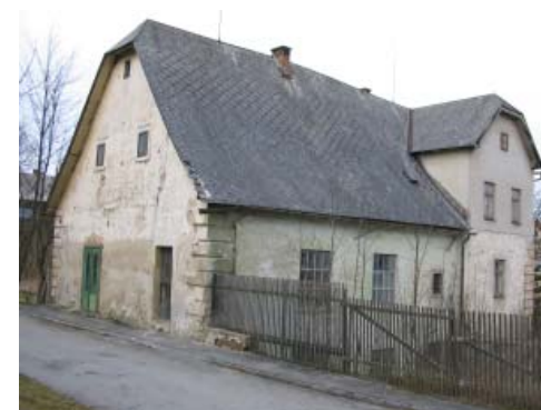
Abb. 3.8.1.6. Weberei Prohaska / ehem. Getreidemühle, 1965 Mühlgasse 1 3812 Groß-Siegharts
