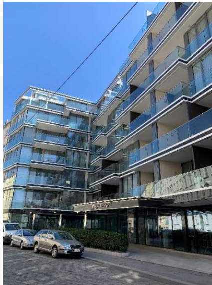
Abbildung 14, Ansicht der Liegenschaft Lage B
