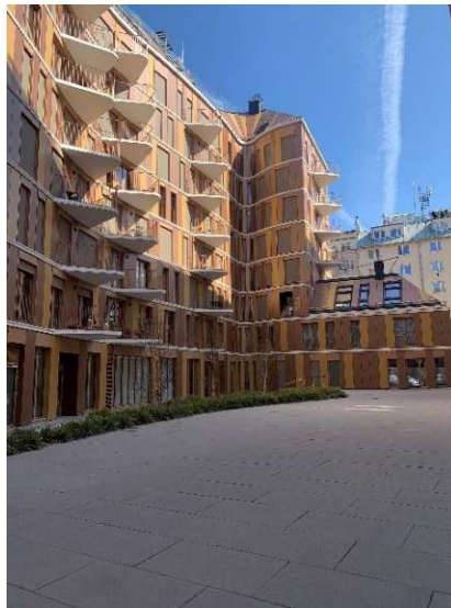
Abbildung 9, Ansicht der Liegenschaft Lage A
